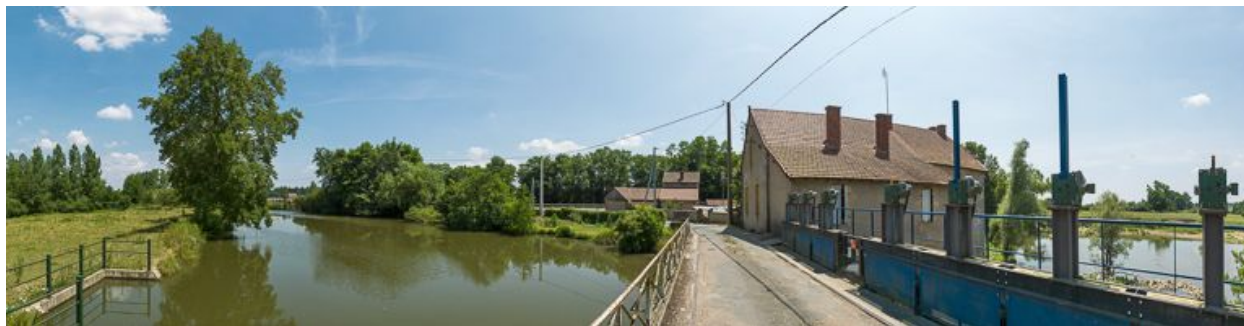
Barrage sur la Bourbince.
