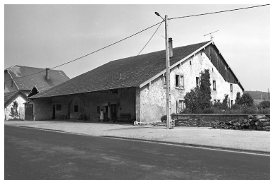
Vue de trois quarts. Phot. Dominique Dominguez IVR43_19792500910X
