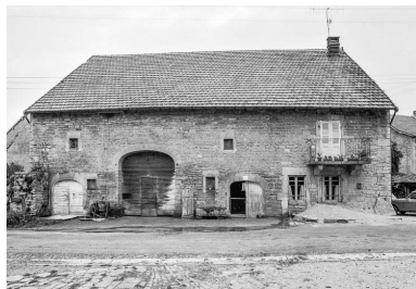
Façade antérieure en 1976. Phot. Bernard Pontefract IVR43_19763900259Z
