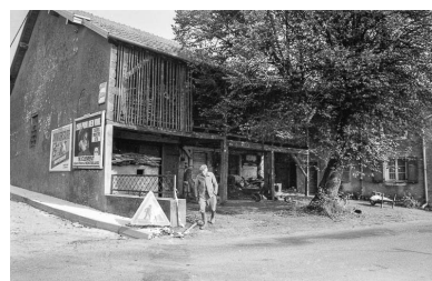
Façade antérieure : détail.
