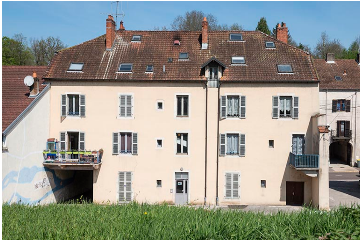
La façade postérieure.
