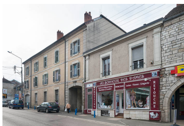
Vue depuis l'ouest. Phot. Jérôme Mongreville IVR43_20177000460NUC4A
