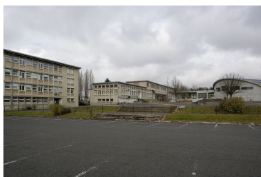
Vue d'ensemble bâtiments D et B. Phot. Yves Sancey IVR43_20072501022NUCA
