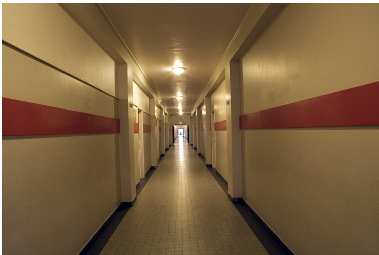
Bâtiment A. Vue couloir.
