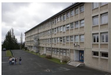
Vue façade latérale bâtiment D. Phot. Yves Sancey IVR43_20072501028NUCA
