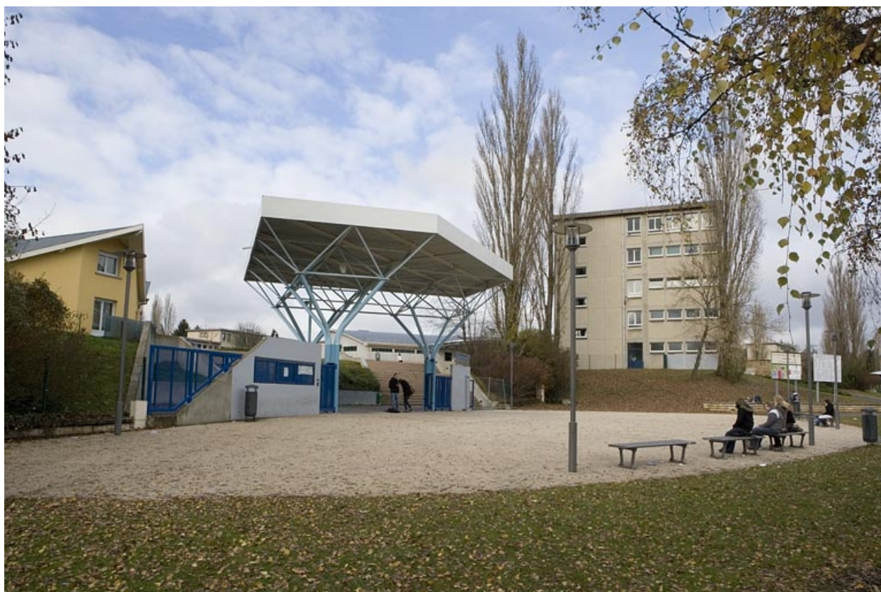
Vue de la nouvelle entrée.
