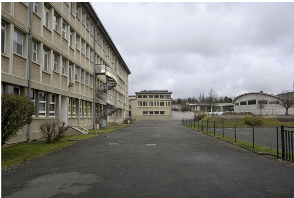
Vue latérale façade antérieure bâtiment D.
