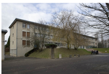
Vue façade antérieure bâtiment C. Phot. Yves Sancey IVR43_20072501030NUCA
