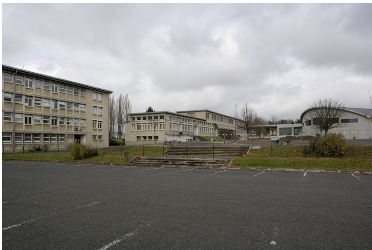
Vue d'ensemble bâtiments D et B.
