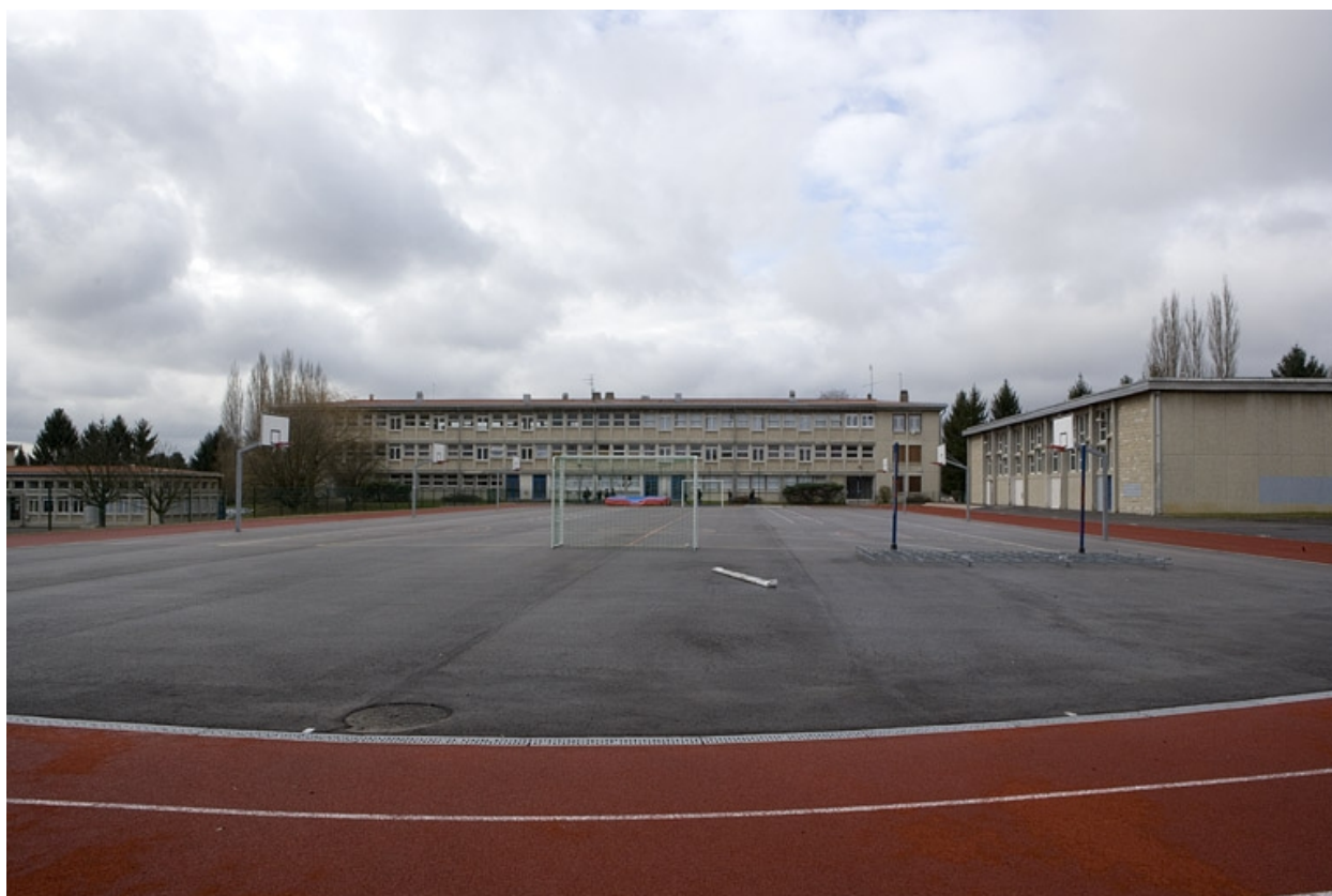
Vue d'ensemble bâtiment F2 et C.
