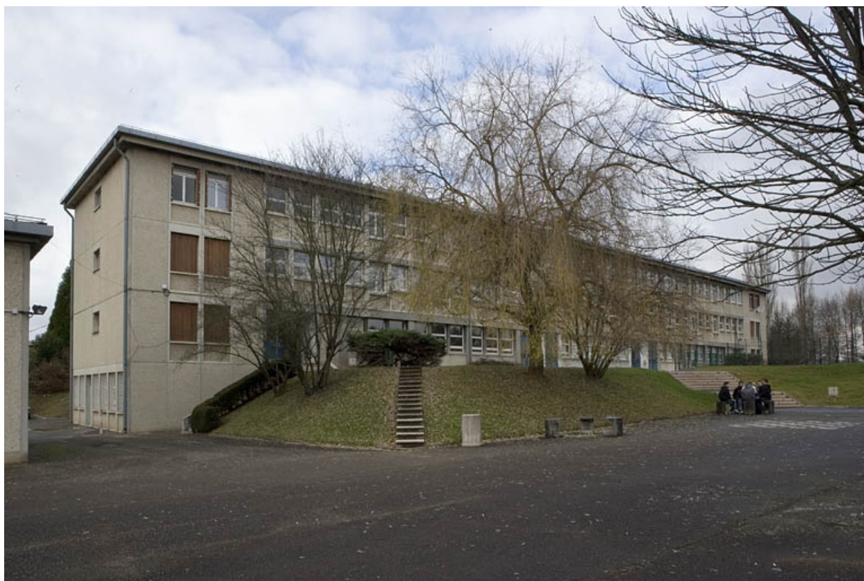
Vue façade antérieure bâtiment C.
