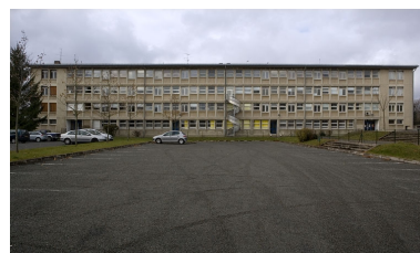
Bâtiment D. Façade antérieure. Phot. Yves Sancey IVR43_20072501021NUCA
