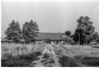
Fontainebrux : ferme cadastrée 1956 A1 151. Phot. Guy Forestier IVR43_19753900212Z
