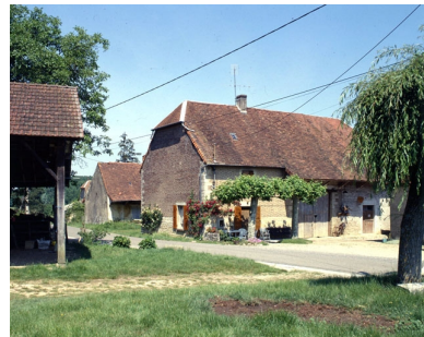
Nance : ferme située rue des Maquisards. Phot. Yves Sancey IVR43_19903901158XA
