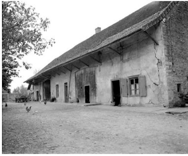
Villevieux : ferme située rue de Beaurepaire. Phot. Yves Sancey IVR43_19793900241X
