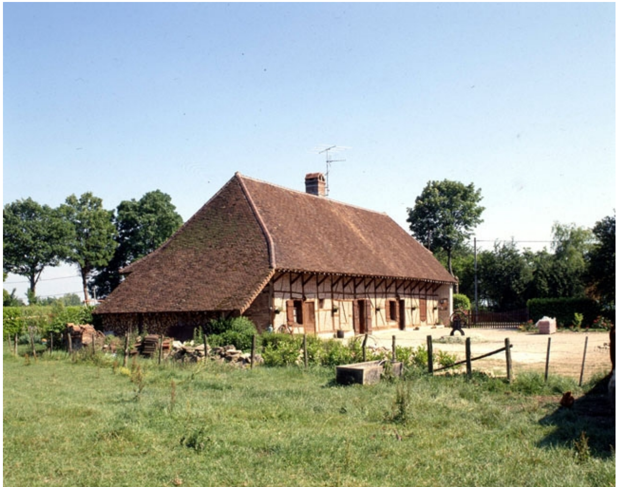
Cosges : ferme située au lieudit Sottessard.
