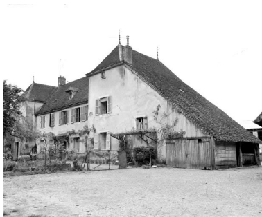
Villevieux : demeure située rue Nationale. Phot. Yves Sancey IVR43_19793900252X
