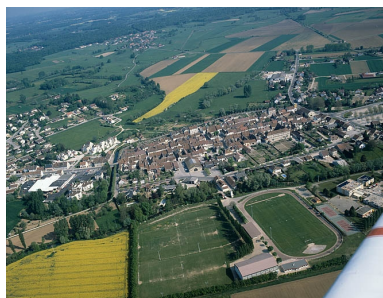
Village : vue aérienne. Phot. Yves Sancey IVR43_19903901095XA
