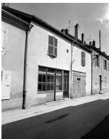
Maison située 53 rue des Granges. Phot. Bernard Lardière IVR43_19793900370X
