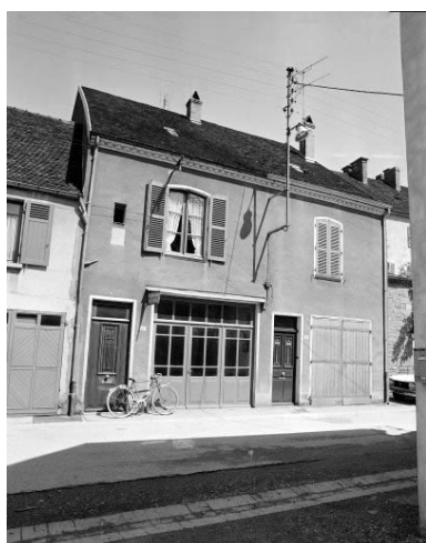
Maison située 41 rue des Granges. Phot. Bernard Lardière IVR43_19793900373X
