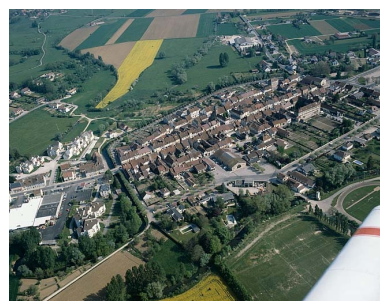
Village : vue aérienne. Phot. Yves Sancey IVR43_19903901094XA
