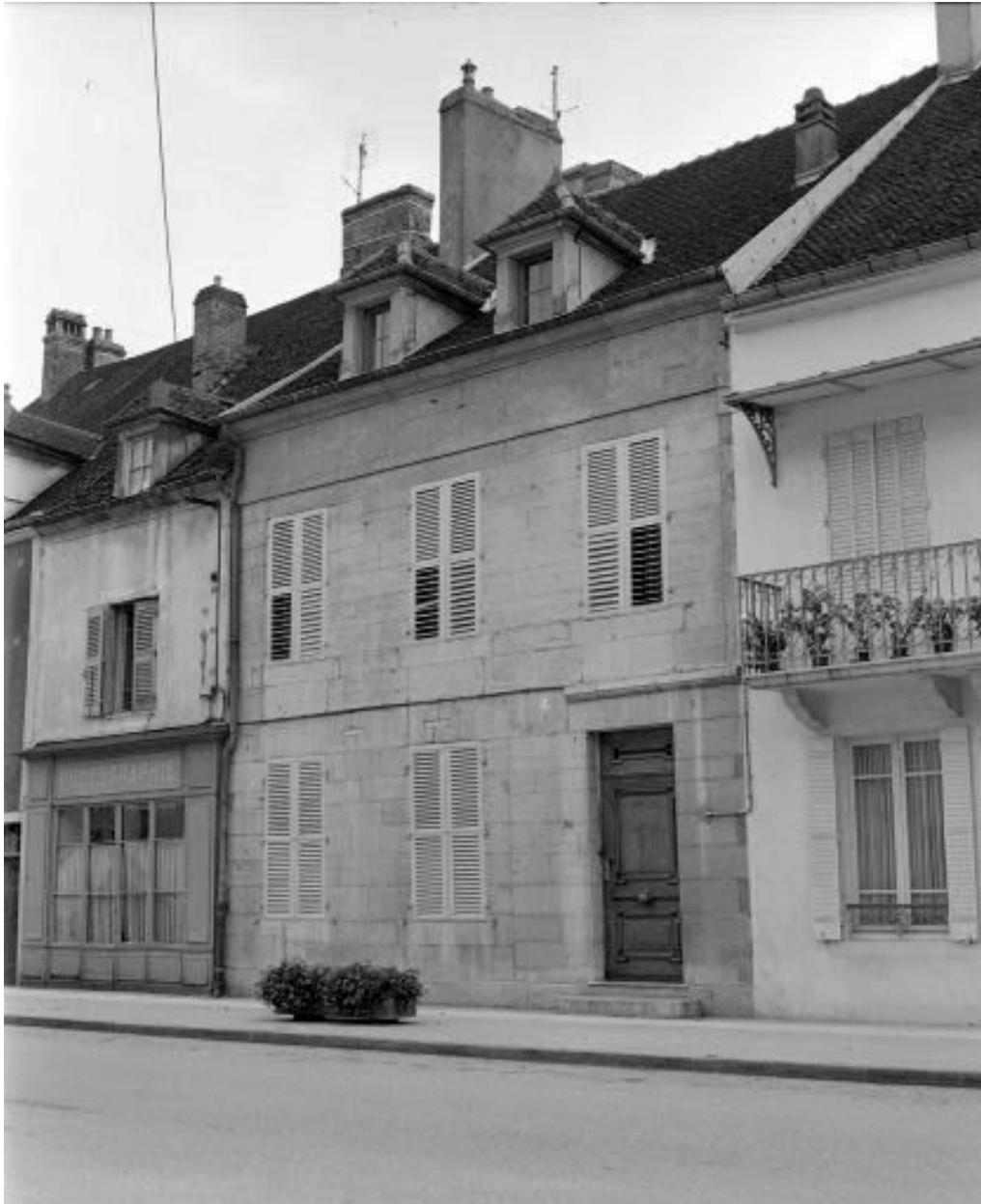
Maison située 76 rue Louis le Grand.
