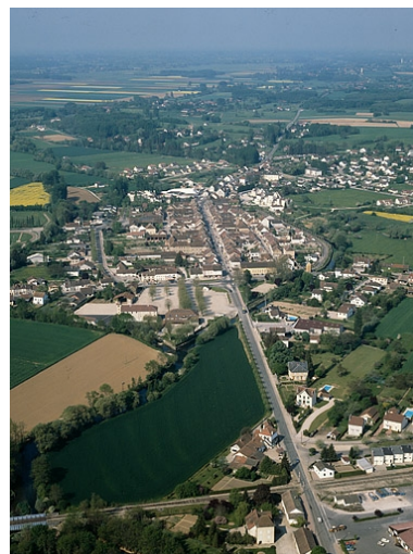
Village : vue aérienne. Phot. Yves Sancey IVR43_19903901097XA
