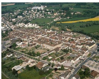
Village : vue aérienne. Phot. Yves Sancey IVR43_19903901099XA
