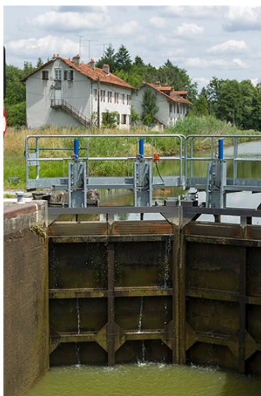
Ecluse n°44 : détail intérieur de la porte amont fermée et vue sur les cités, Demangeville (70). Phot. Sonia Dourlot IVR43_20157000960NUC2A
