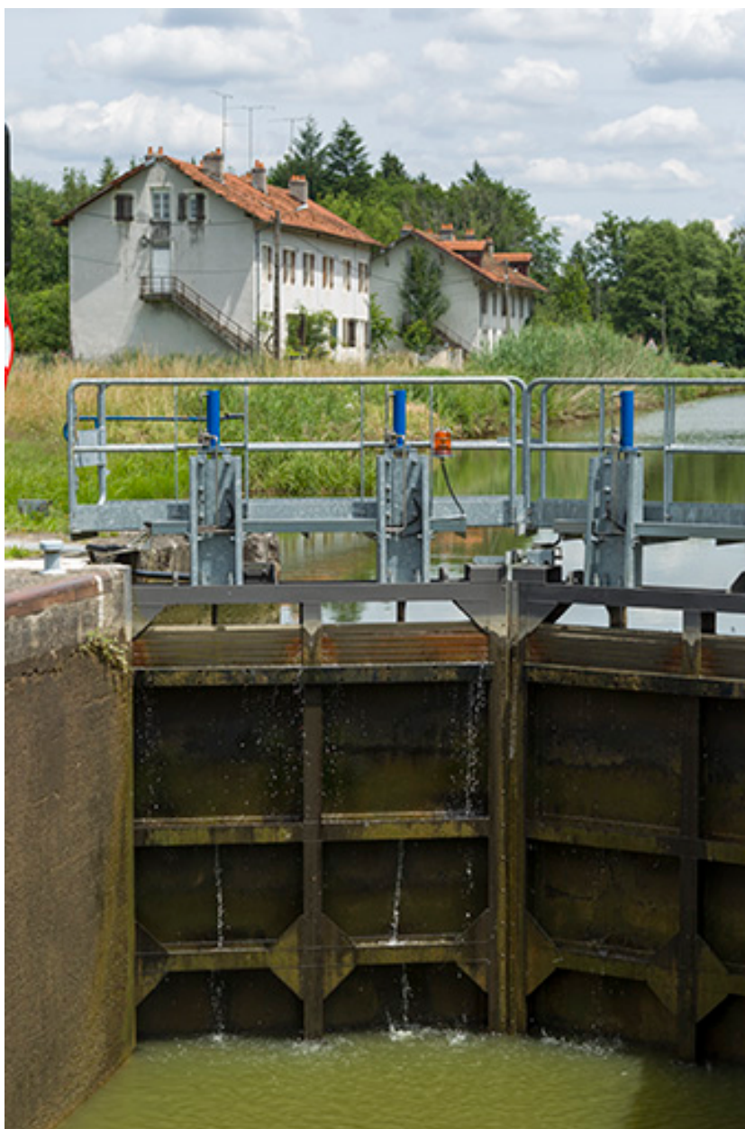
Ecluse n°44 : détail intérieur de la porte amont fermée et vue sur les cités, Demangeville (70).
