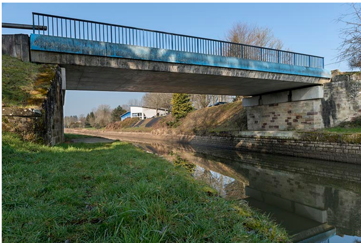
Pont routier enjambeant le canal, Pont-du-Bois (70).
