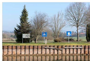
Détail des palplanches le long de la berge. Phot. Sonia Dourlot IVR43_20167000198NUC4A
