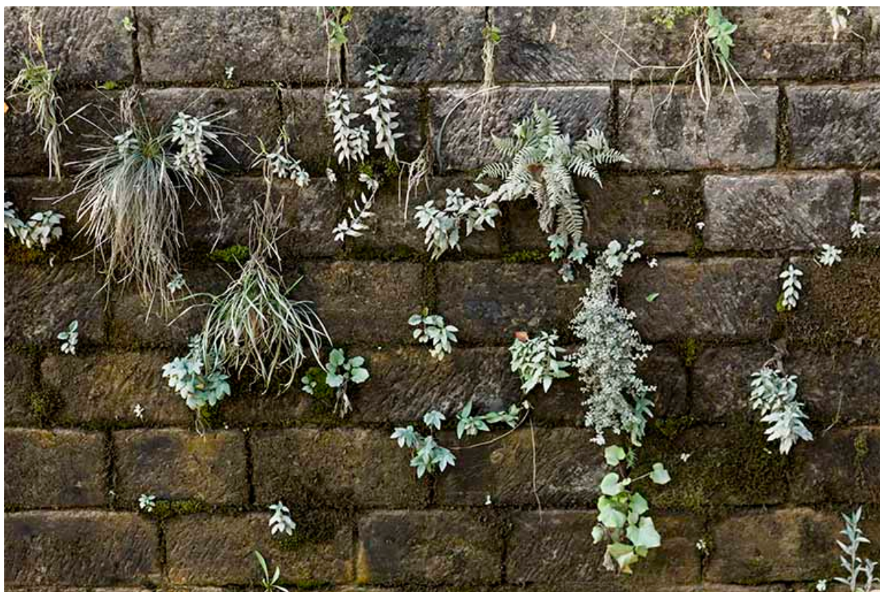
Détail sur la maçonnerie d'une écluse.
