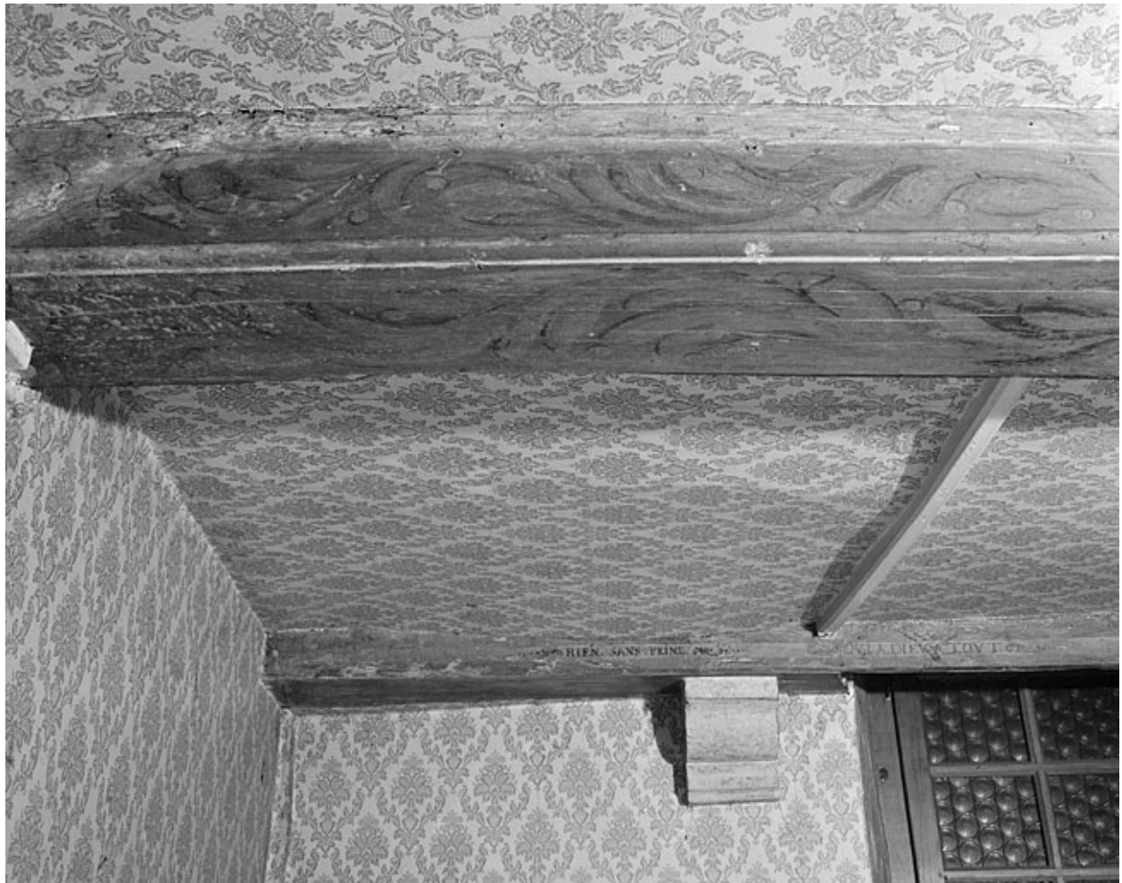
Premier corps de bâtiment. Plafond du rez-de-chaussée.
