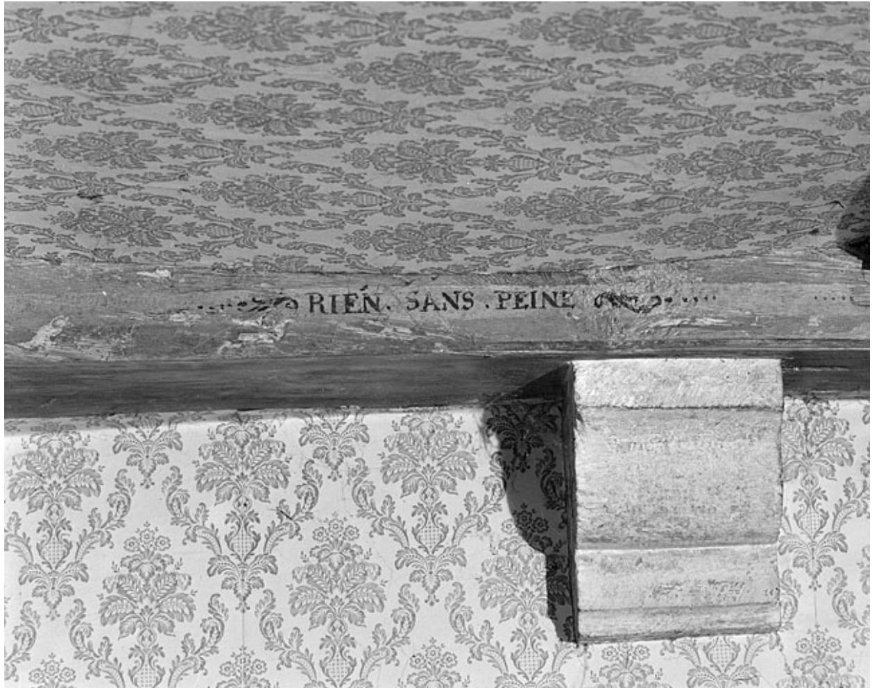
Premier corps de bâtiment. Plafond du rez-de-chaussée.
