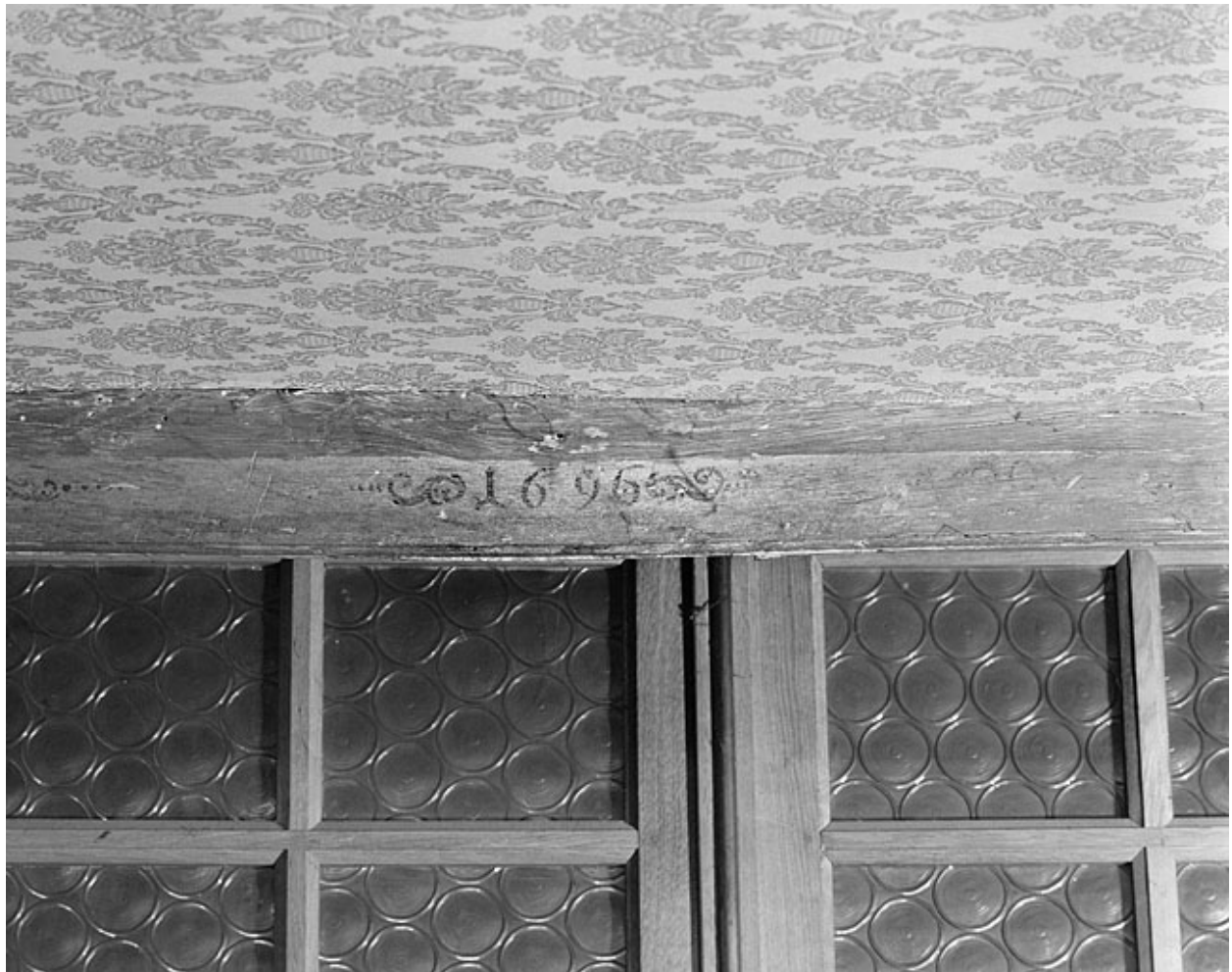
Premier corps de bâtiment. Plafond du rez-de-chaussée.
