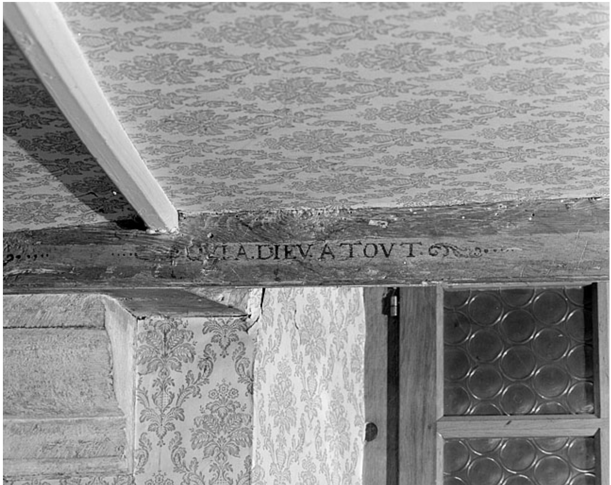
Premier corps de bâtiment. Plafond du rez-de-chaussée.
