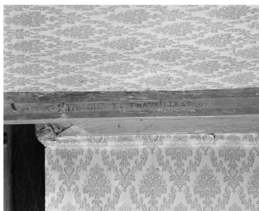
Premier corps de bâtiment. Plafond du rez-de-chaussée. Phot. Yves Sancey IVR43_19852500058X
