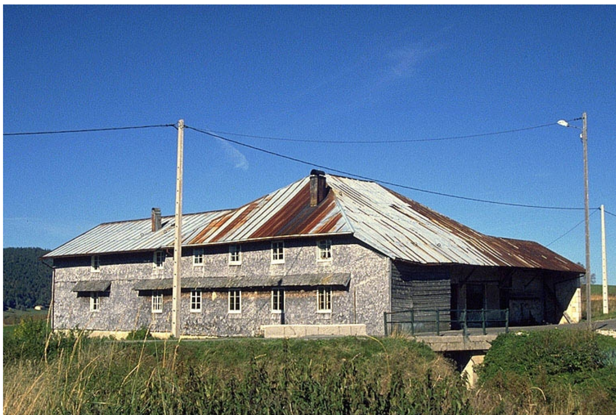
Bâtiment vu de trois quarts gauche.
