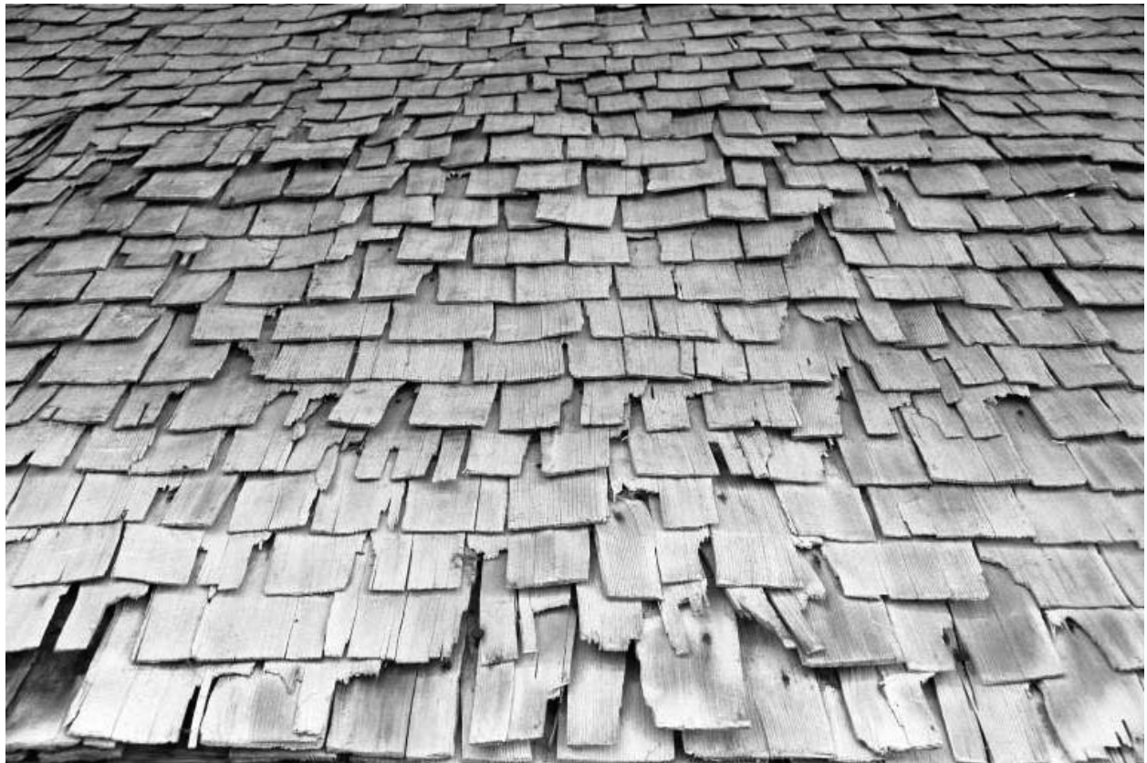
Détail de l'essentage de la façade antérieure.
