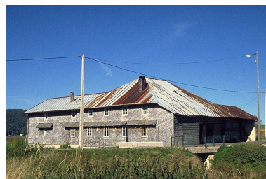
Bâtiment vu de trois quarts gauche. Phot. Laurent Poupard IVR43_19903900630ZA
