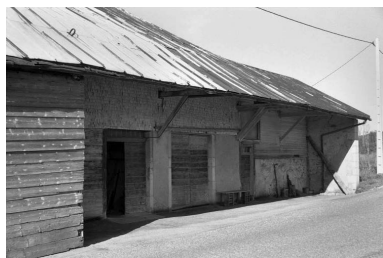
Façade antérieure. Phot. Laurent Poupard IVR43_19903900631Z
