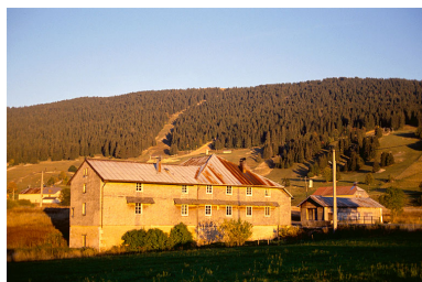
Vue d'ensemble depuis l'ouest. Phot. Laurent Poupard IVR43_19903900628ZA
