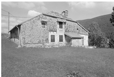
Face sud-ouest. Phot. Jérôme Mongreville IVR43_19963901584X
