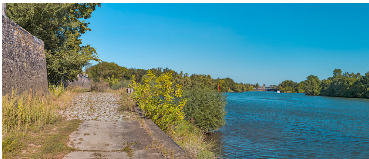
Pavage et ponceau sur la rive droite.
