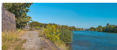
Pavage et ponceau sur la rive droite.
