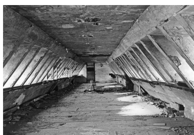
Usine Japy, à Badevel, en 1978 : intérieur du deuxième étage de comble de l'atelier d'horlogerie. Phot. Jérôme Mongreville, Autr. Patrick Blandin Patrick (photographe) IVR43_20122500677NUC2A
