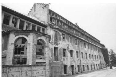
Usine japy, à Badevel, en 1979 : atelier d'horlogerie. Phot. J. Dumont IVR43_19792501145Z
