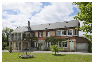
Usine Boname-Beaudroit, à Seloncourt (23-25 rue d'Audincourt). Phot. Jérôme Mongreville IVR43_20122501074NUC4A
