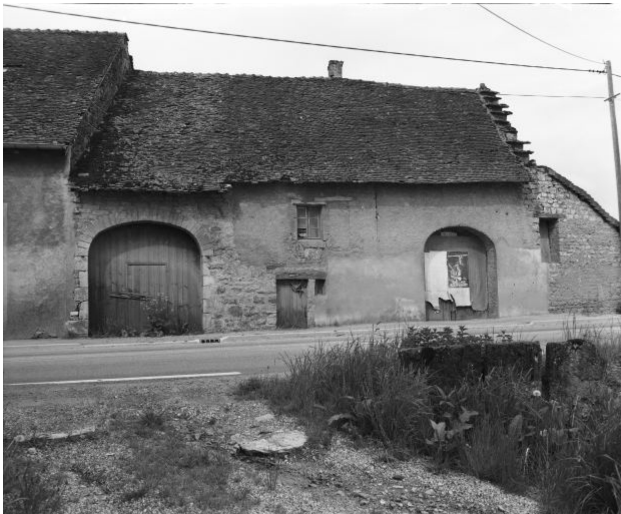
Façade antérieure vue de face.
