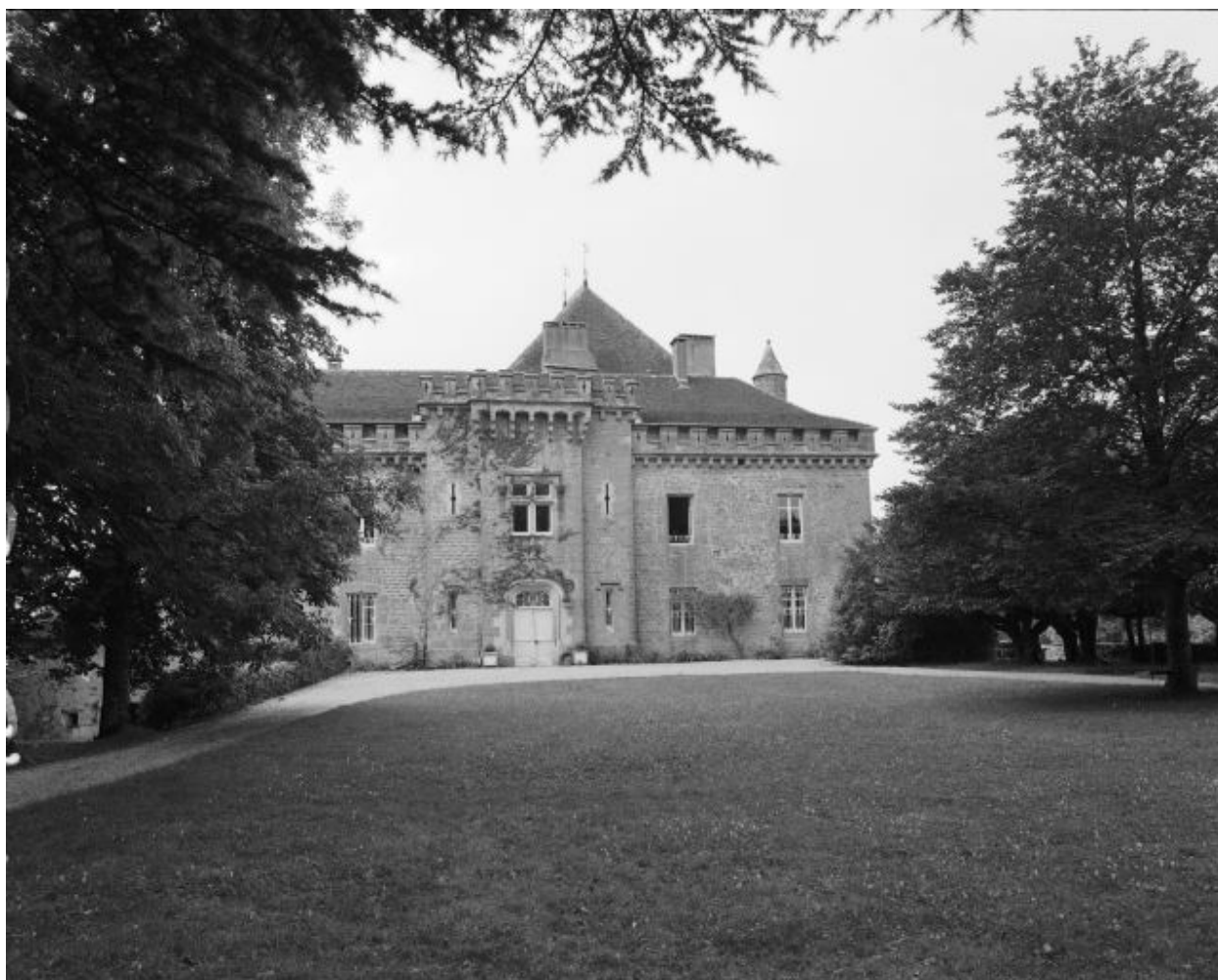
Le corps de bâtiment de façade.
