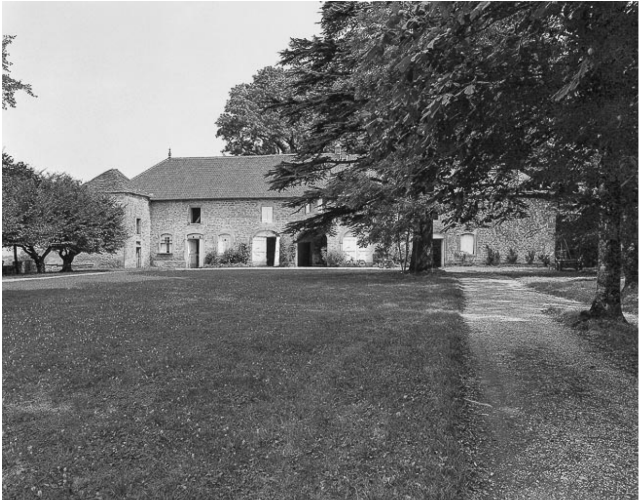
Communs du château fort : façade vue depuis la cour.
