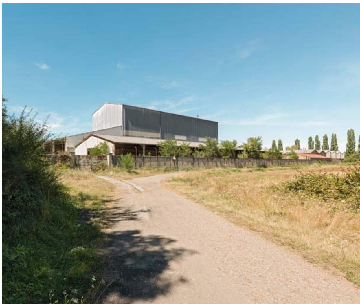
Vue générale du site.
