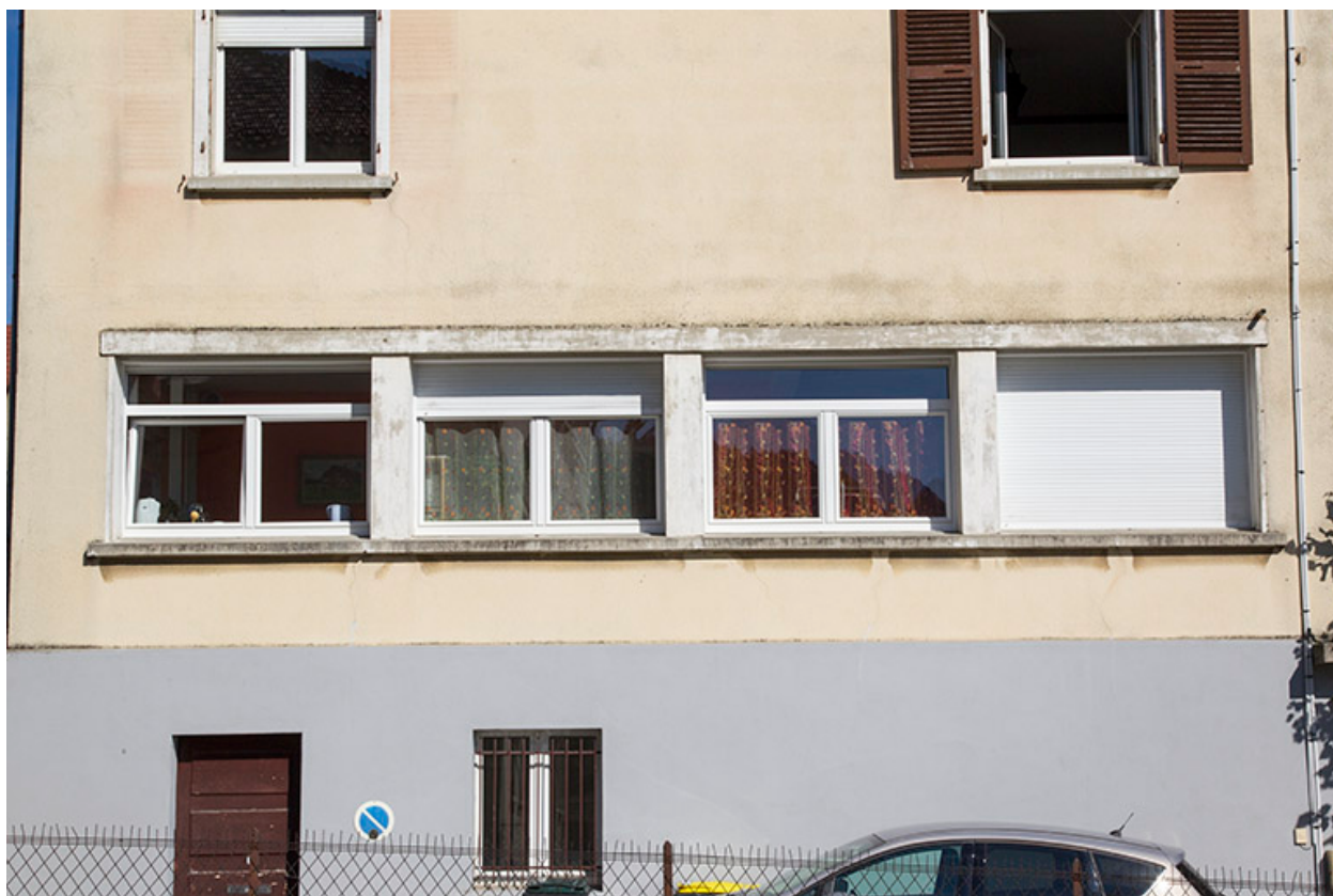
Façade latérale gauche : fenêtres d'atelier.
