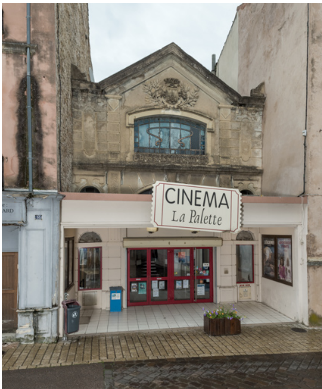
Façade antérieure, rue de la République.
