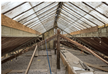
Charpente métallique et verrière, depuis le côté du quai. Phot. Pierre-Marie Barbe-Richaud IVR26_20257100372NUC4A
