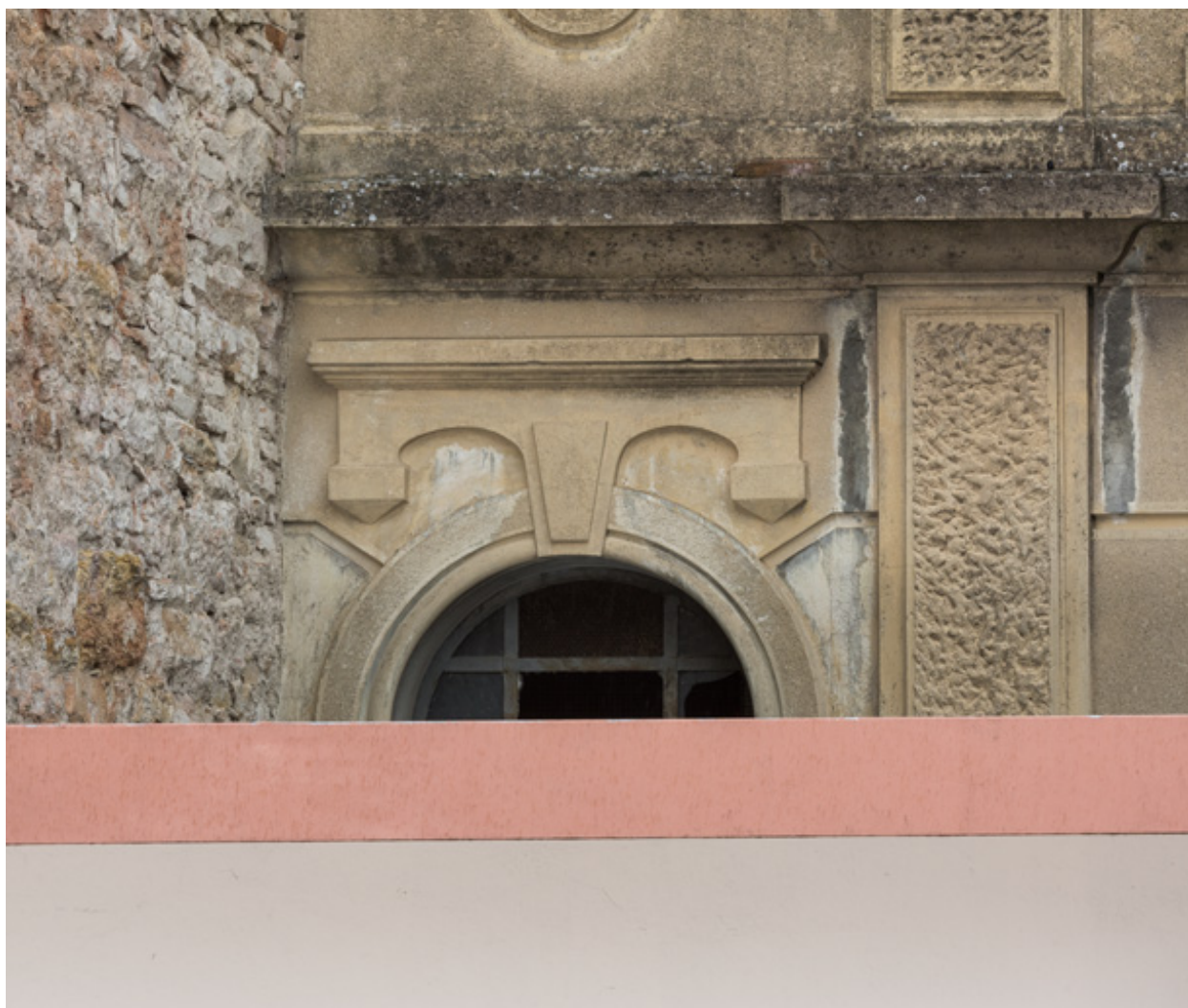
Façade antérieure : décor surmontant une fenêtre.
