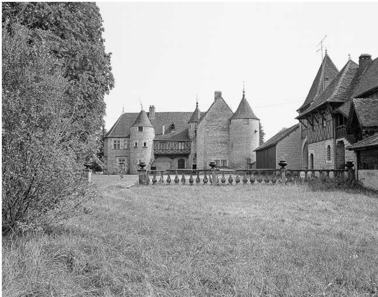
Vue générale depuis l'est
