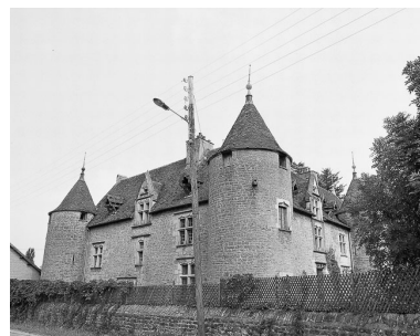
Façade sud et est Phot. Yves Sancey IVR43_19753901075X
