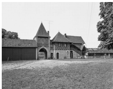
Bâtiment d'entrée : façade nord. Phot. Yves Sancey IVR43_19753901076X
