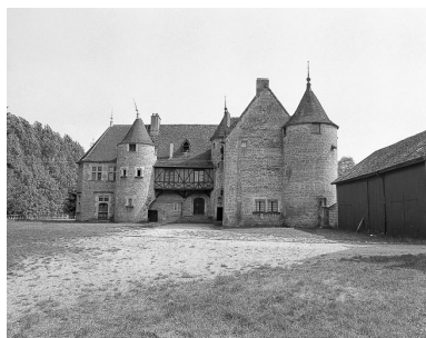
Façade ouest Phot. Yves Sancey IVR43_19753901073X
