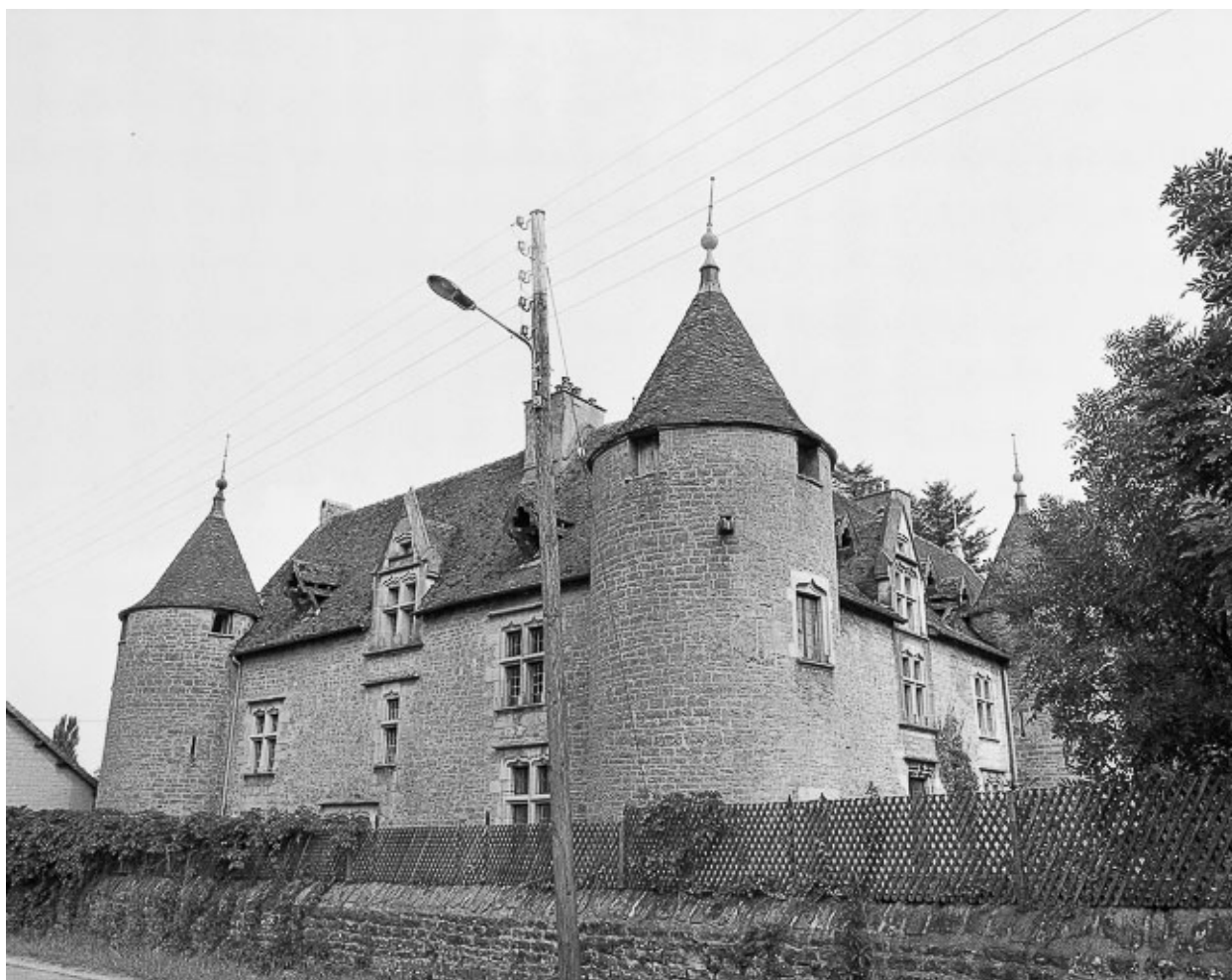
Façade sud et est
