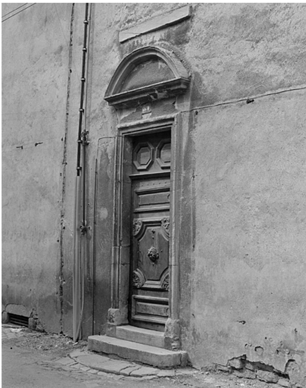
Façade latérale, porte d'entrée.
