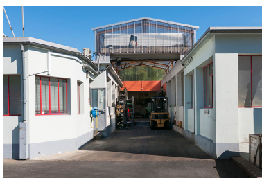
Passage couvert entre l'atelier original et son extension (à droite). Phot. Jérôme Mongreville IVR43_20152501725NUC4A
