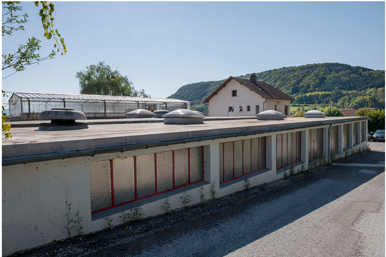
Façade sur rue de l'atelier de fabrication.
