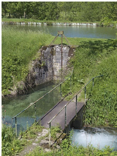
Aqueduc et déversoir régulant l'eau du bief 21.
