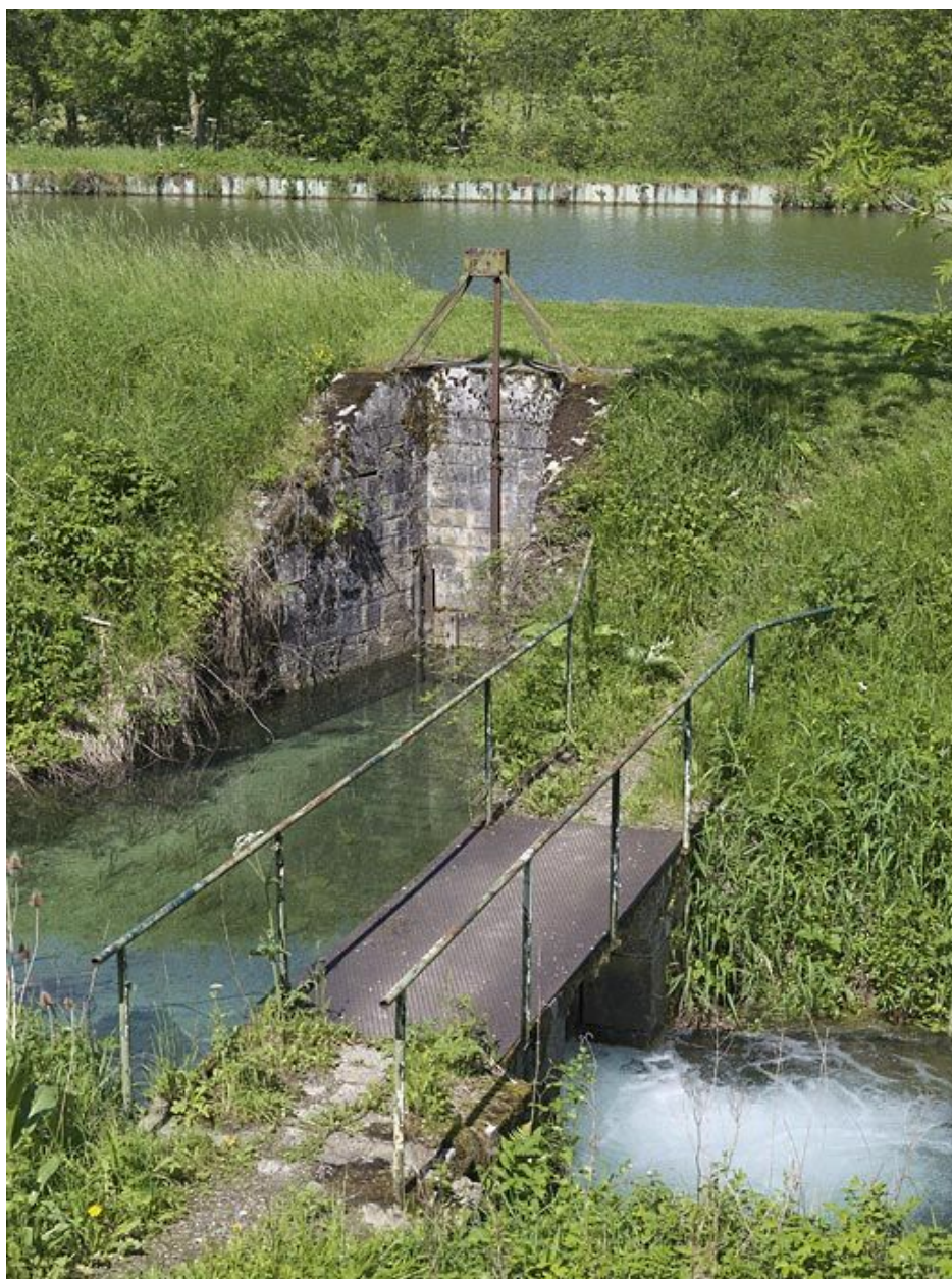
Aqueduc et déversoir régulant l'eau du bief 21.
