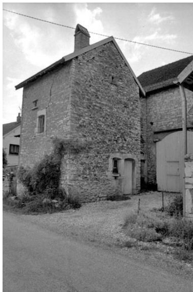
L'habitation gauche. Phot. Bernard Lardière IVR43_19817000516Z
