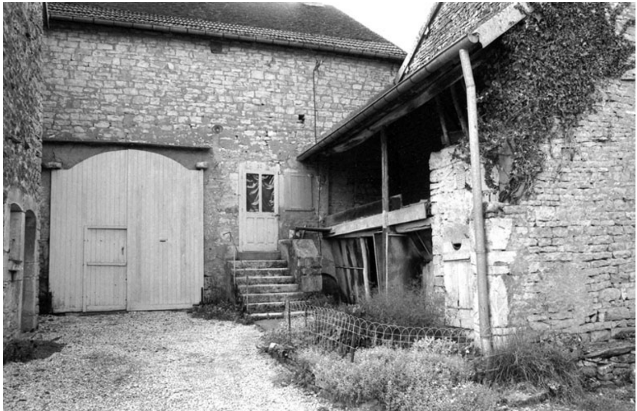
Le bâtiment en fond de cour.
