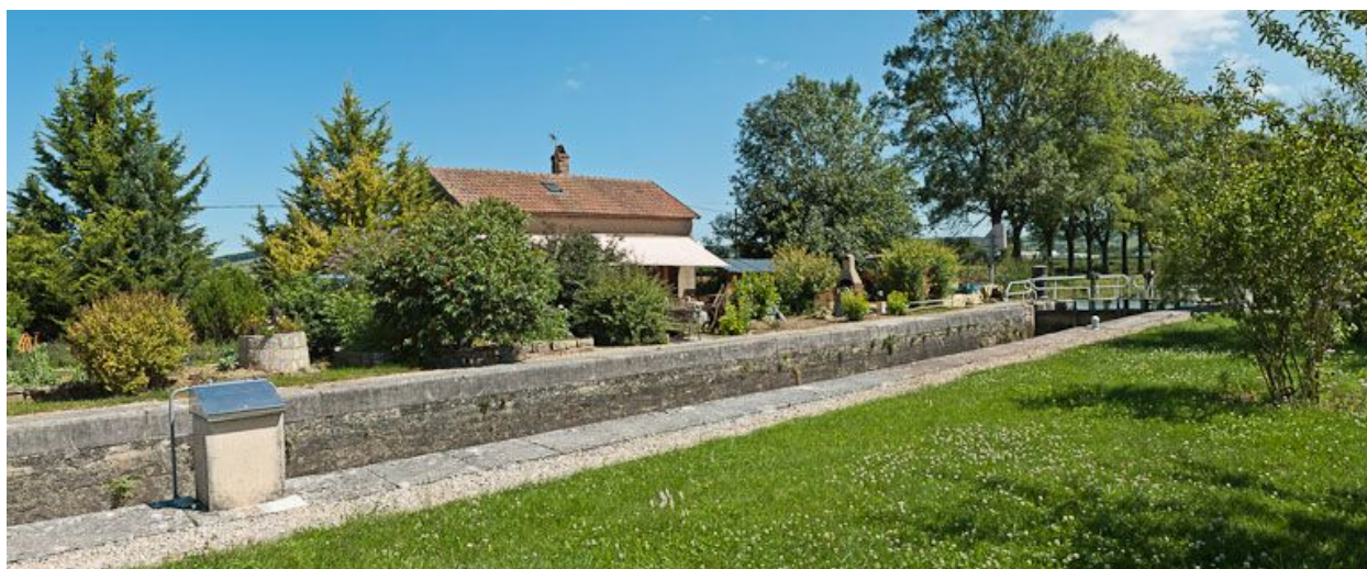
Vue d'ensemble du site d'écluse.
