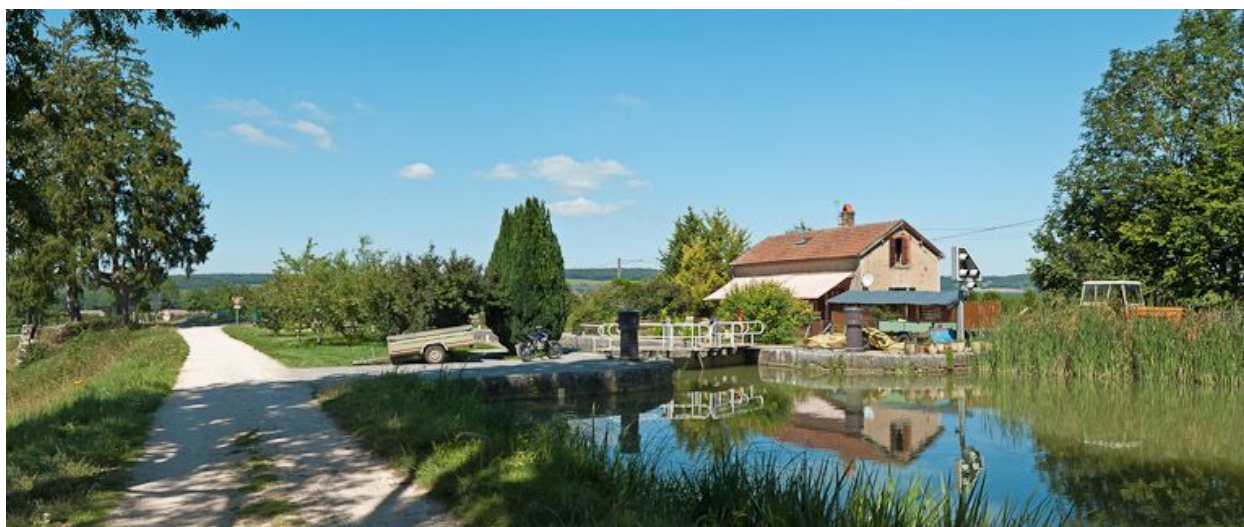
Vue d'ensemble du site d'écluse.
