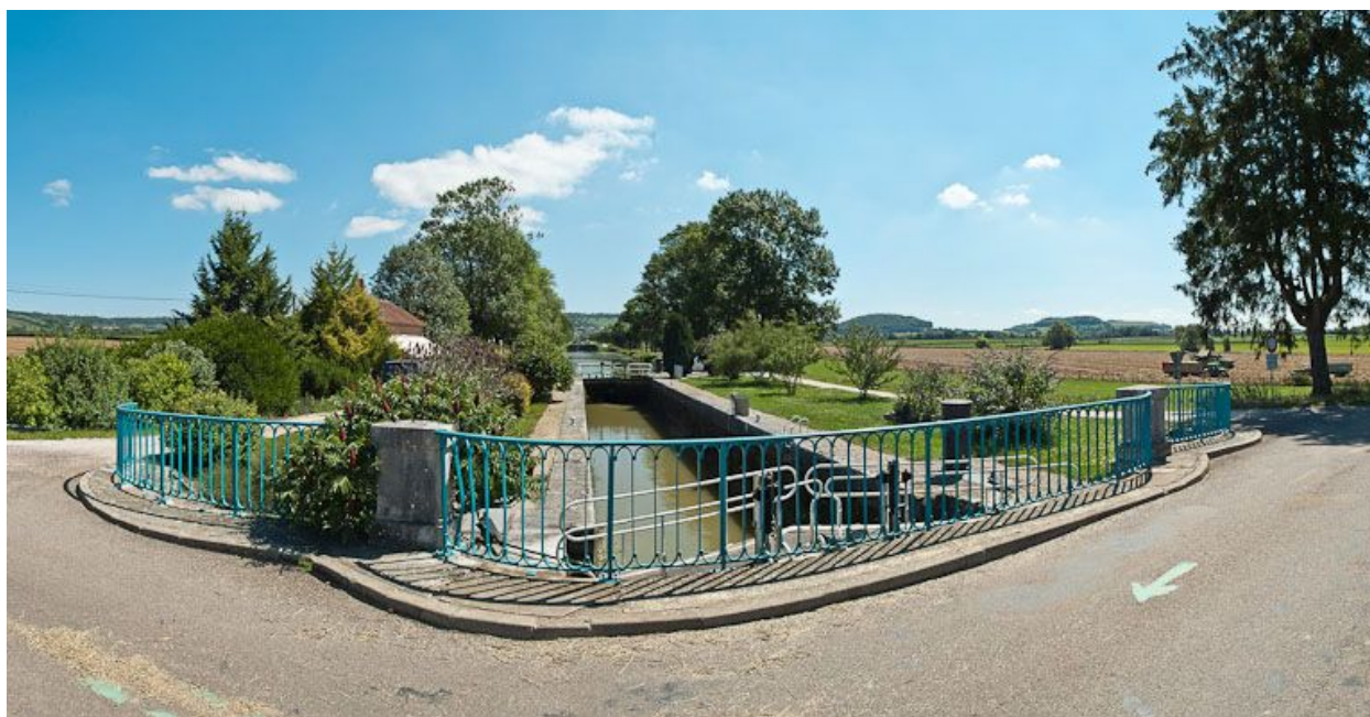
Vue du sas d'écluse depuis le pont.
