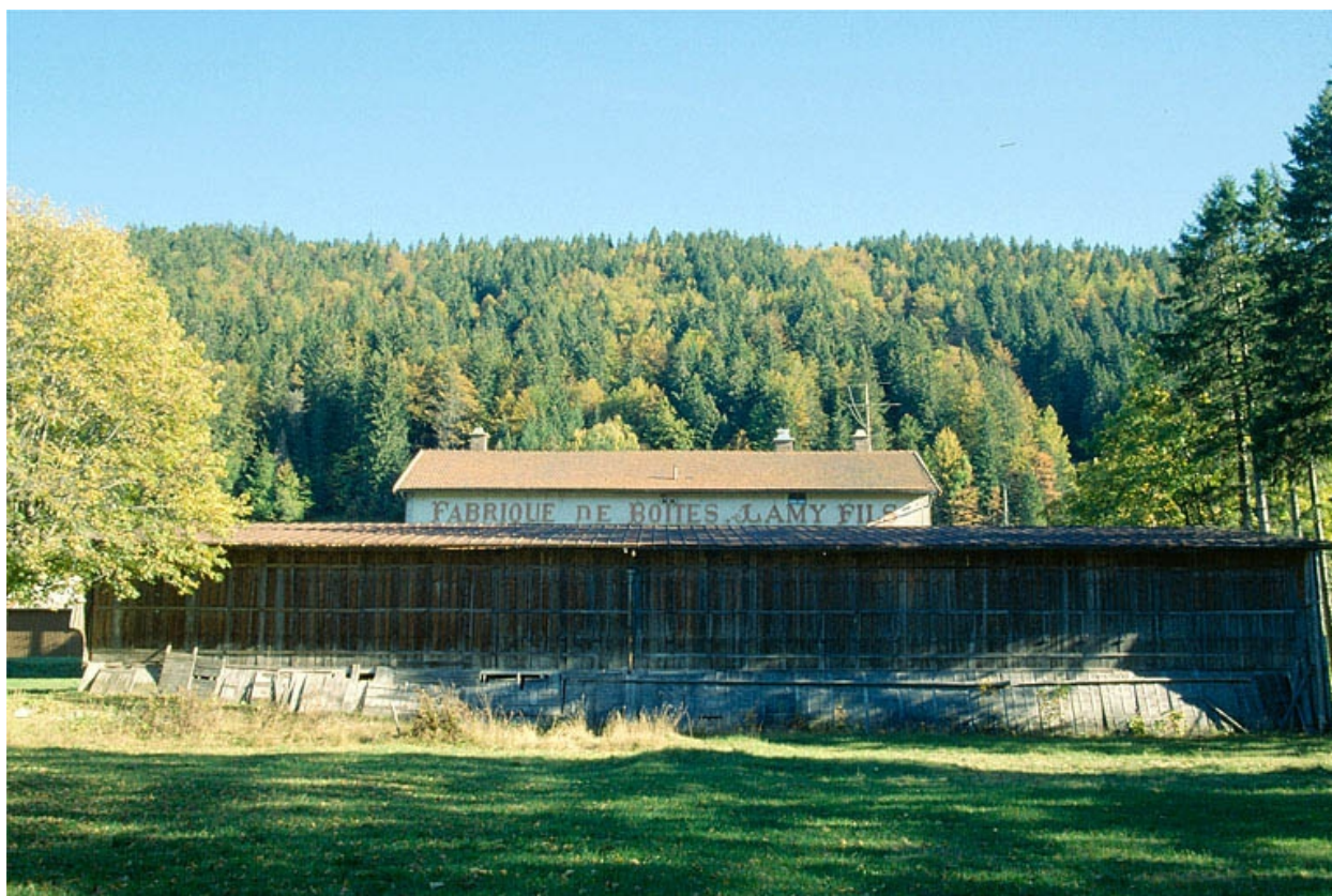
Façade postérieure du séchoir.
