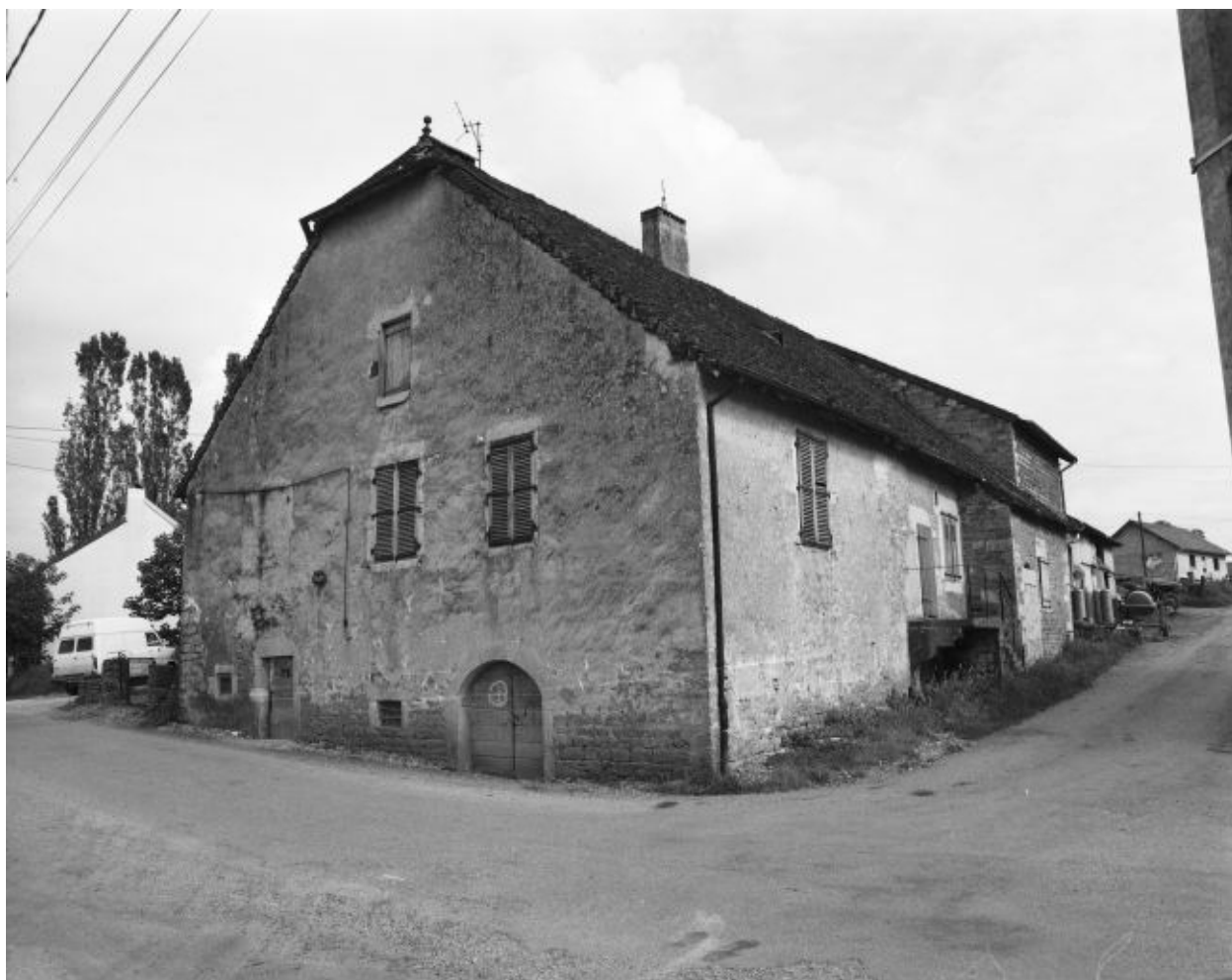
Façades postérieure et latérale droite.
