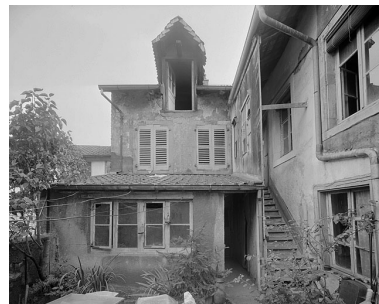
Deuxième corps de bâtiment. Phot. Jérôme Mongreville IVR43_19872501105V
