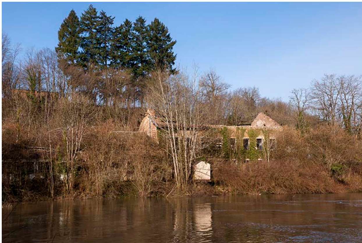
Atelier de fabrication incendié.
