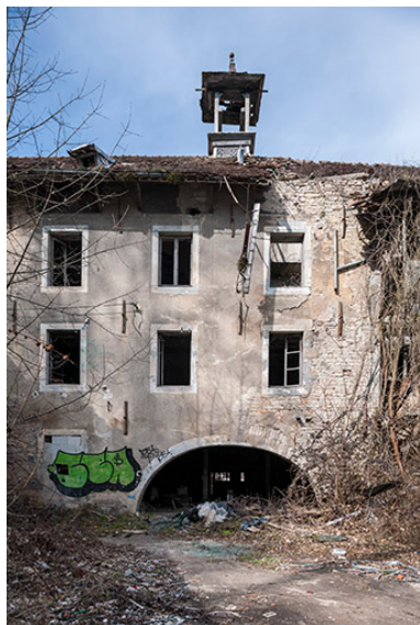
Façade sud de l'atelier principal. Phot. Jérôme Mongreville IVR43_20152500383NUC4A
