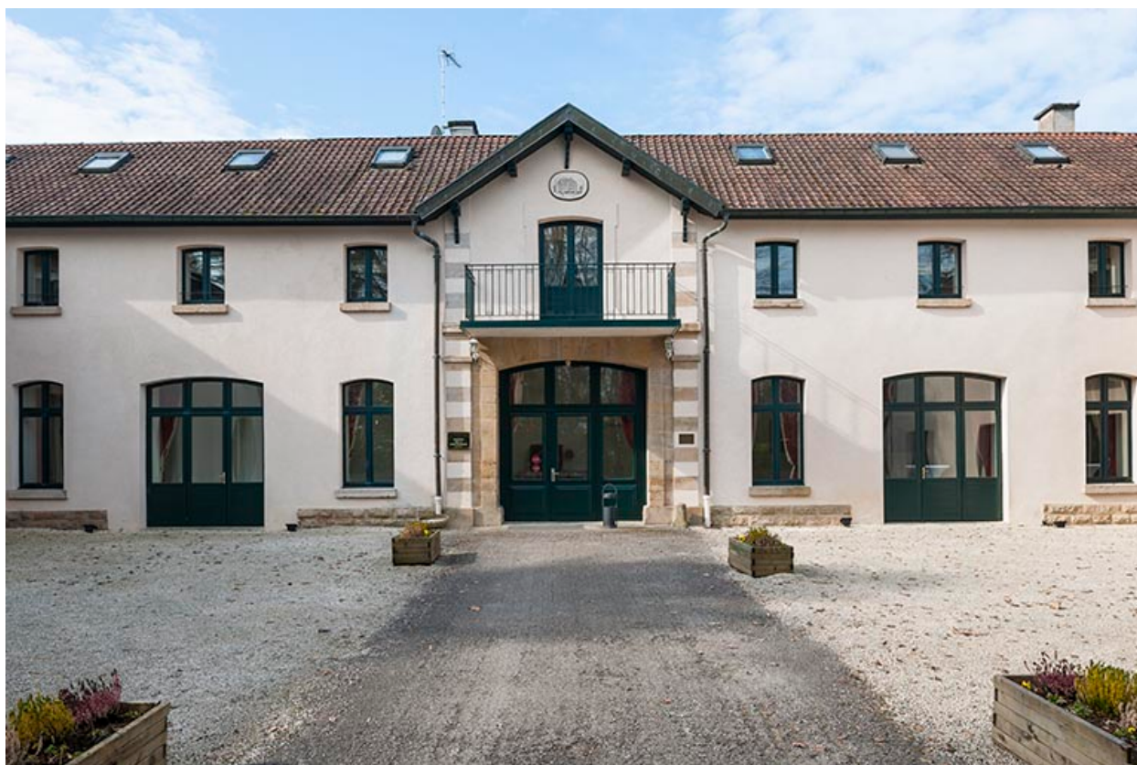
Bâtiment des communs. Travée centrale.
