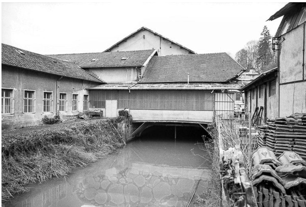
Canal de fuite principal en 1979.
