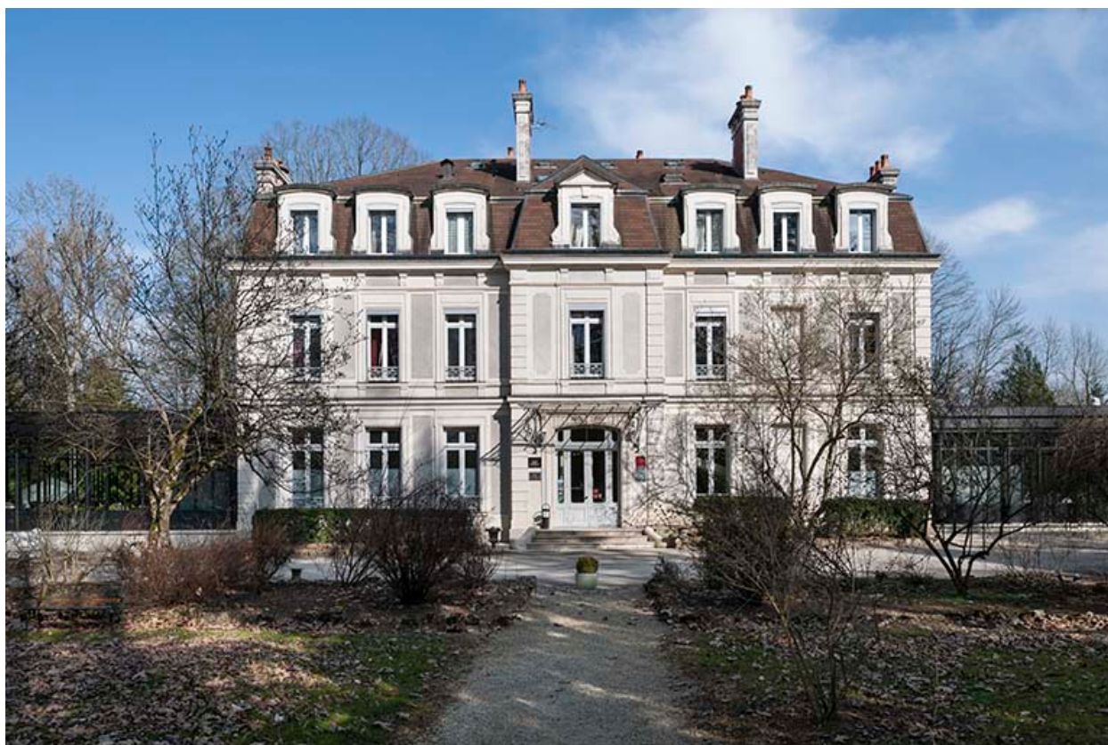
Logement patronal. Façade ouest.
