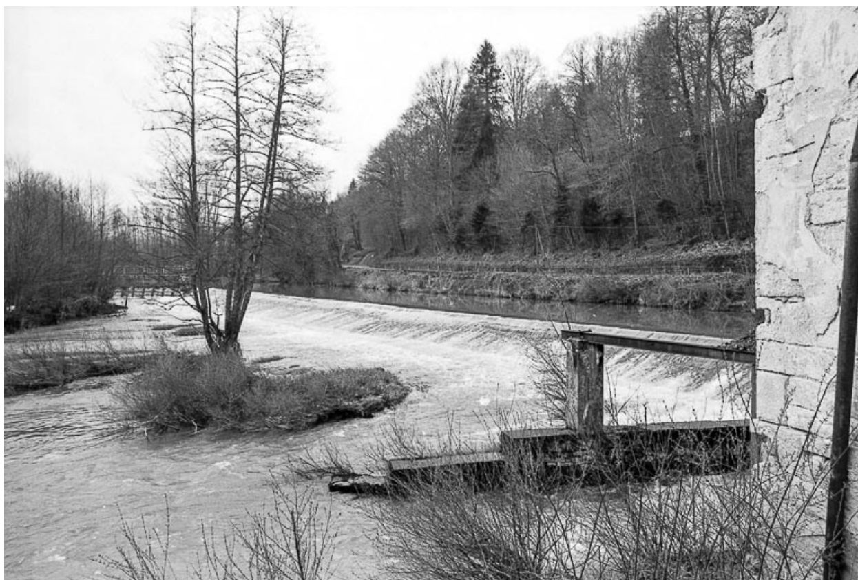
Le barrage depuis la papeterie en 1979.
