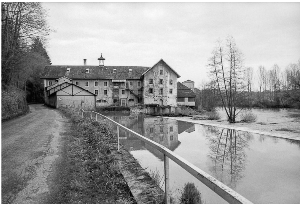
Vue d'ensemble depuis le sud en 1979.
