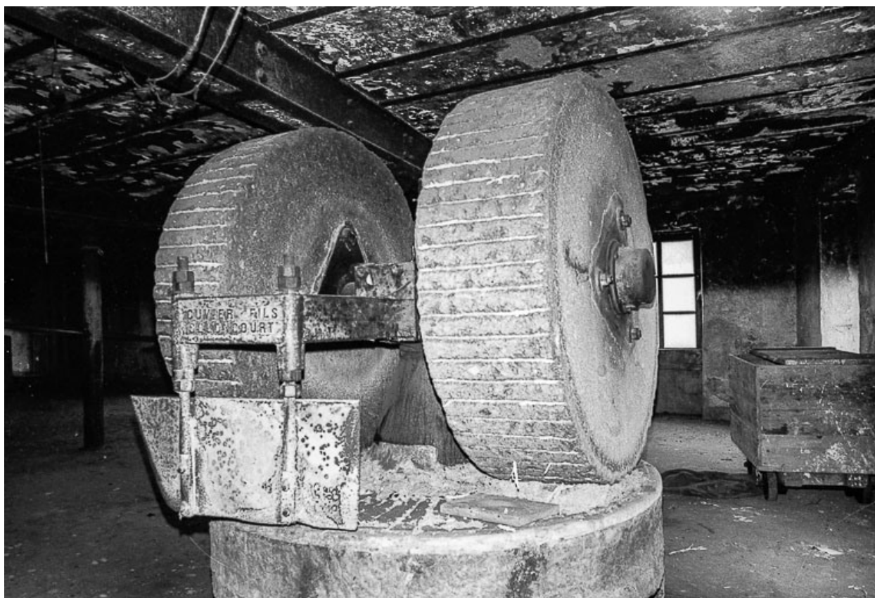
Meuleton (meules de broyage) du constructeur Cuvier (Seloncourt) en 1979.
