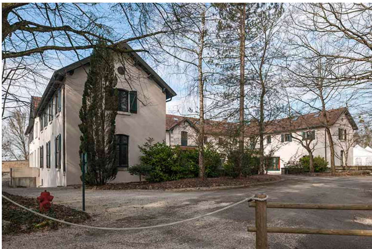
Bâtiment des communs. Vue depuis le sud-est.
