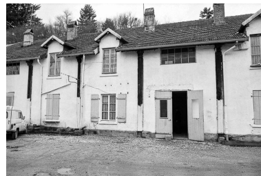
Logements ouvriers dans le site en 1979. Phot. J. Dumont IVR43_19792501129Z
