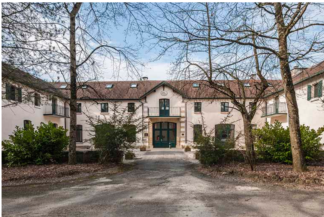
Bâtiment des communs. Vue axiale.
