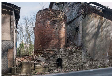
Base de la cheminée et la chaufferie. Phot. Jérôme Mongreville IVR43_20152500378NUC4A
