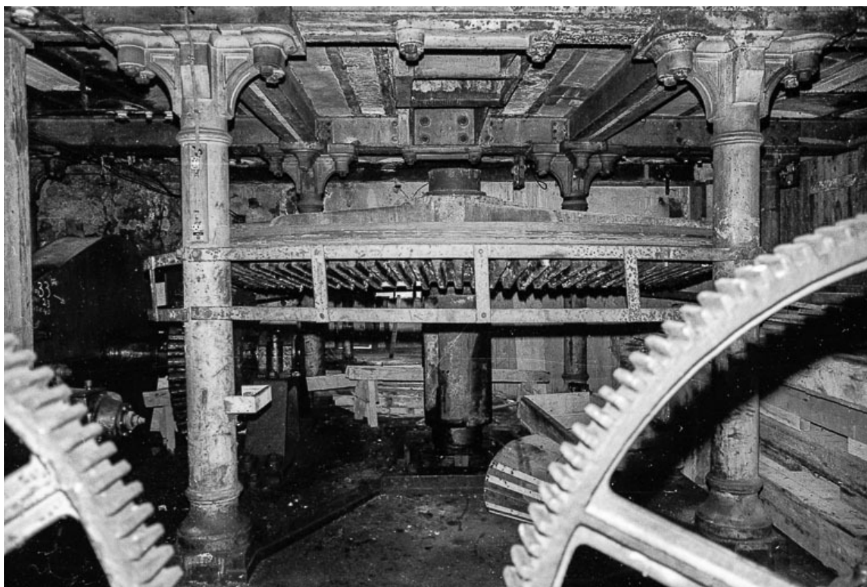
Mécanisme de transmission de la turbine (canal principal) en 1979.
