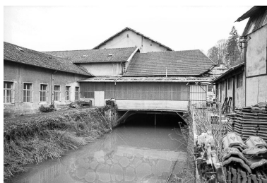
Canal de fuite principal en 1979. Phot. J. Dumont IVR43_19792501124Z
