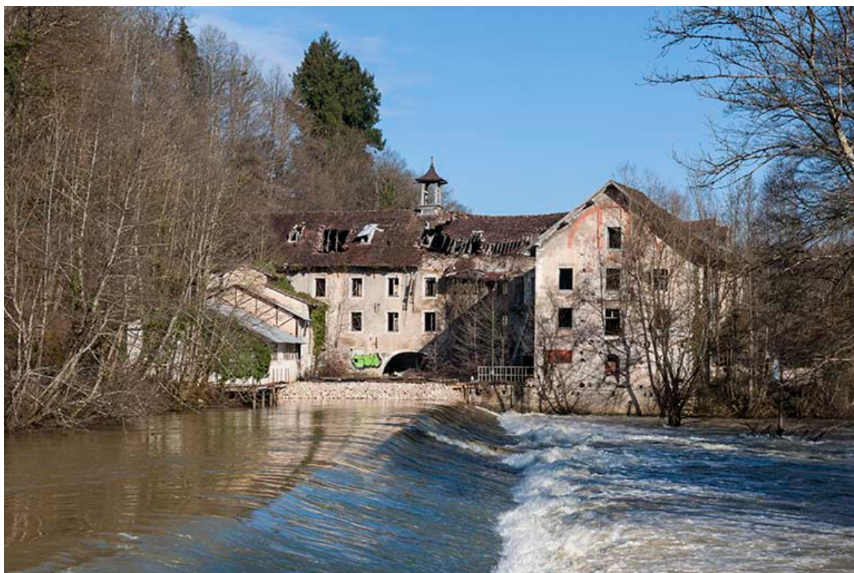
Vue depuis la rive droite du barrage.
