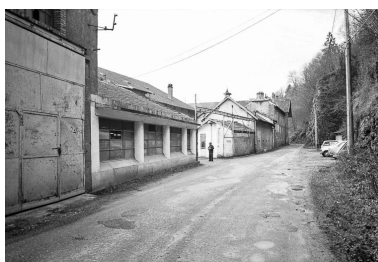
Alignement de façades sur la route d'accès en 1979. Phot. J. Dumont IVR43_19792501125Z
