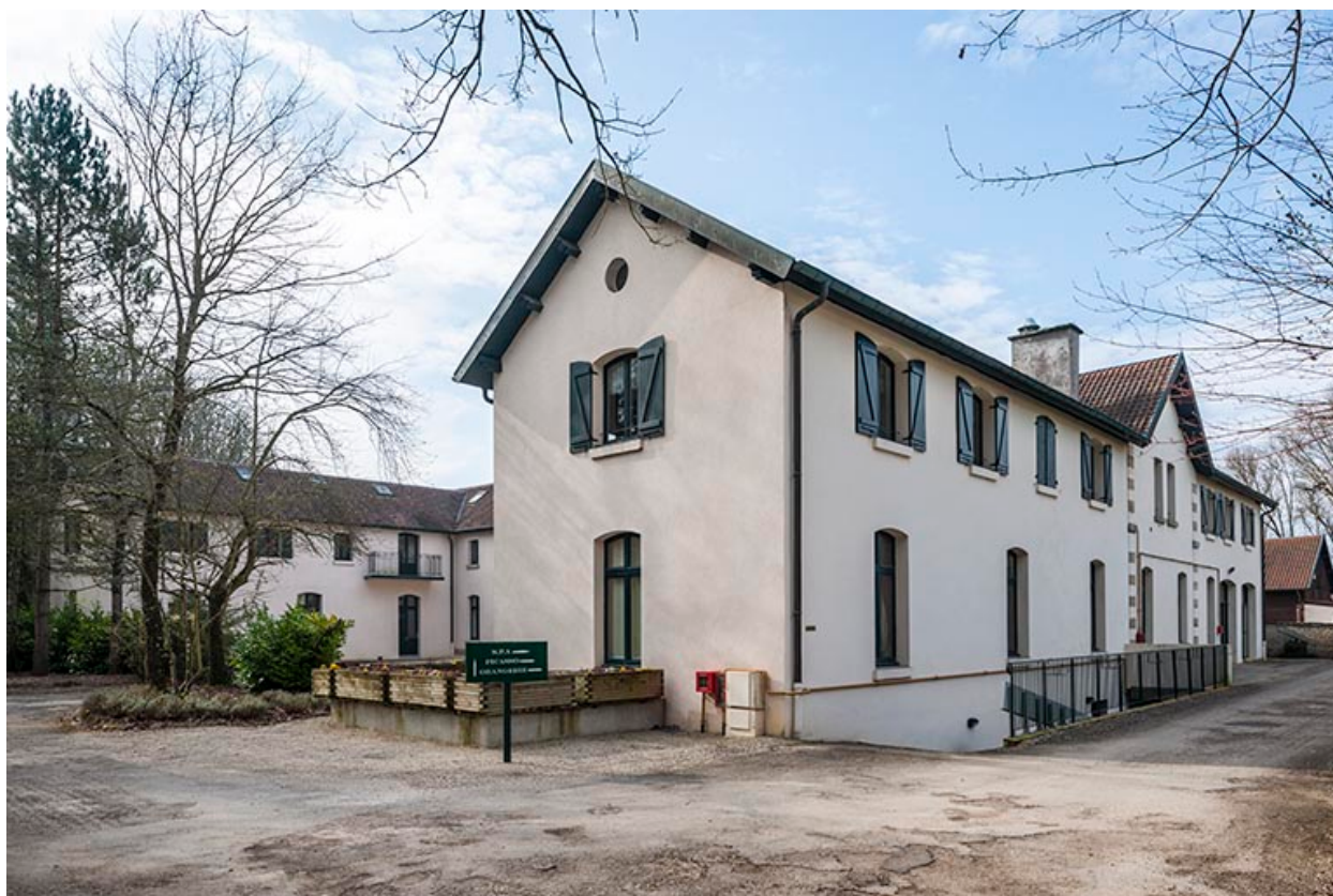
Vue d'ensemble du bâtiment des communs.
