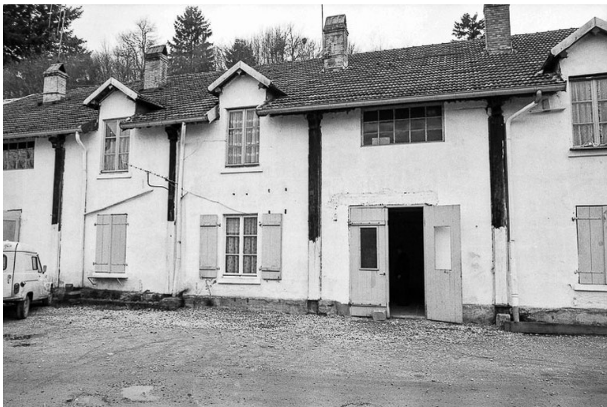
Logements ouvriers dans le site en 1979.
