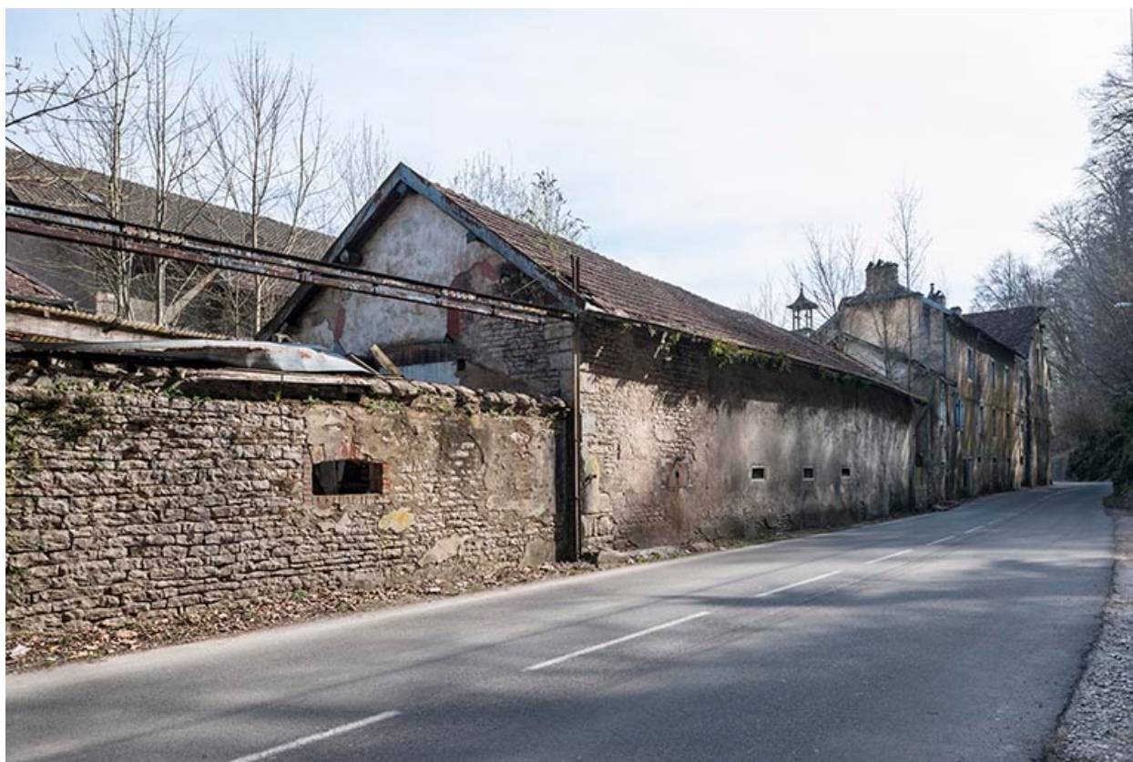
Magasin industriel et logements.
