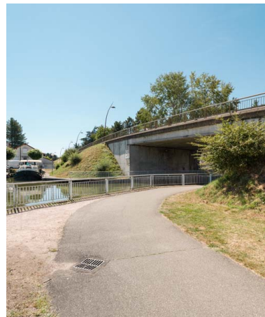
Vue générale du pont. Phot. Pierre-Marie Barbe-Richaud IVR26_20177100236NUC2A
