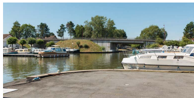
Vue générale du site et du pont. Phot. Pierre-Marie Barbe-Richaud IVR26_20177100234NUC2AQ
