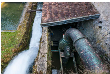
Déversoir (à gauche) et conduite forcée de la turbine. Phot. Jérôme Mongreville IVR43_20152500417NUC4A
