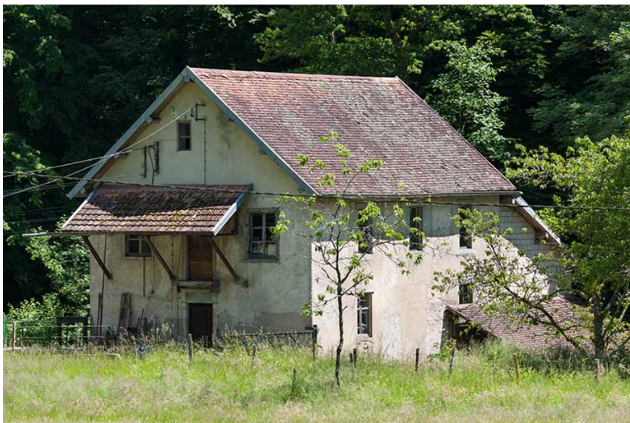
Vue rapprochée du moulin, depuis l'ouest.
