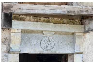
Mur-pignon ouest. Détail du linteau. Phot. Jérôme Mongreville IVR43_20152500416NUC4A
