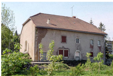
Façade postérieure. Phot. Yves Sancey IVR43_19993900076ZA
