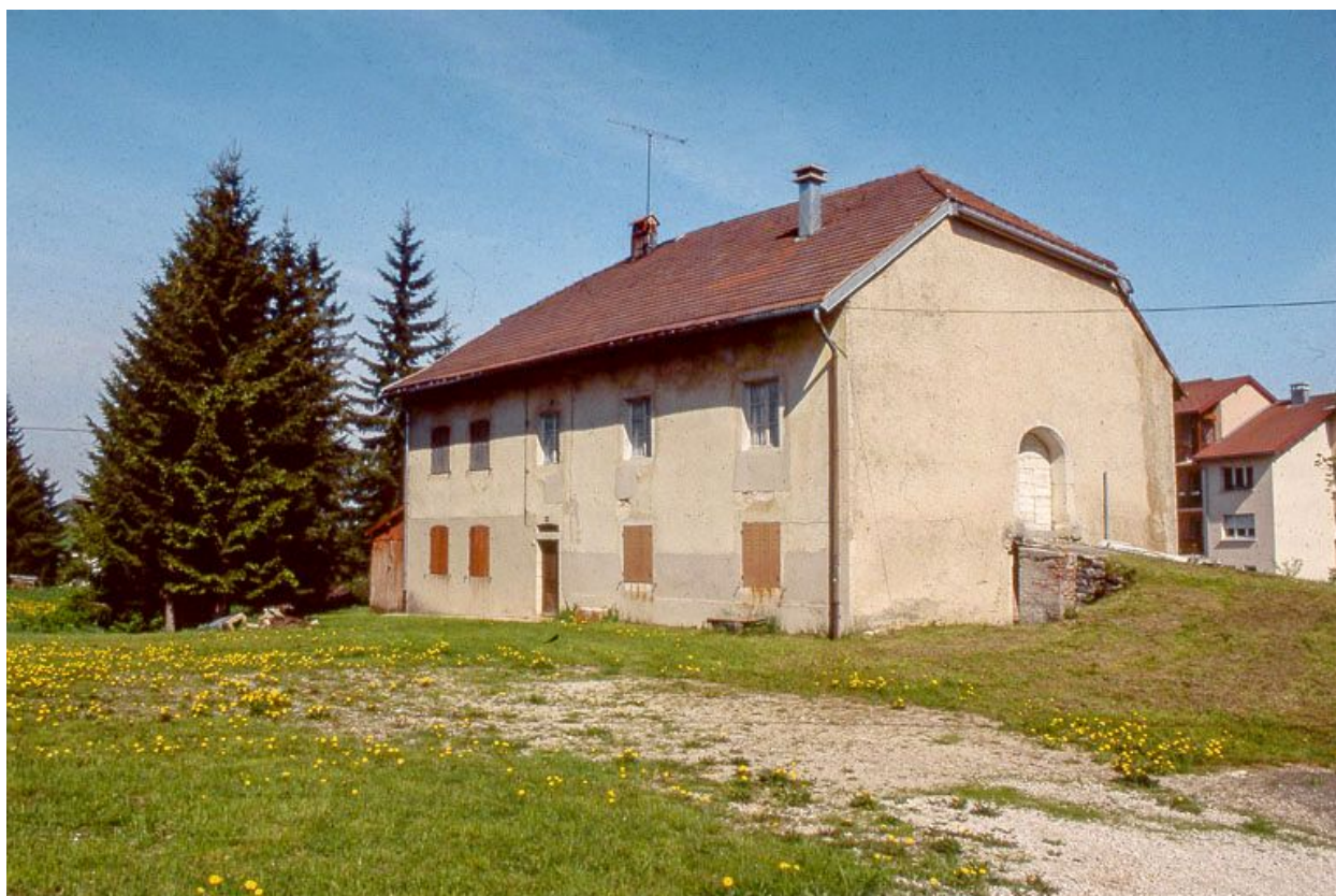
Façade antérieure et face droite.
