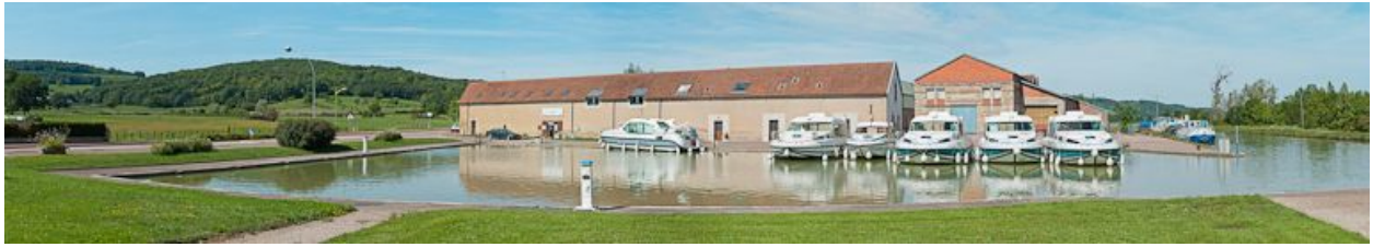
Vue du bassin secondaire rive gauche.
