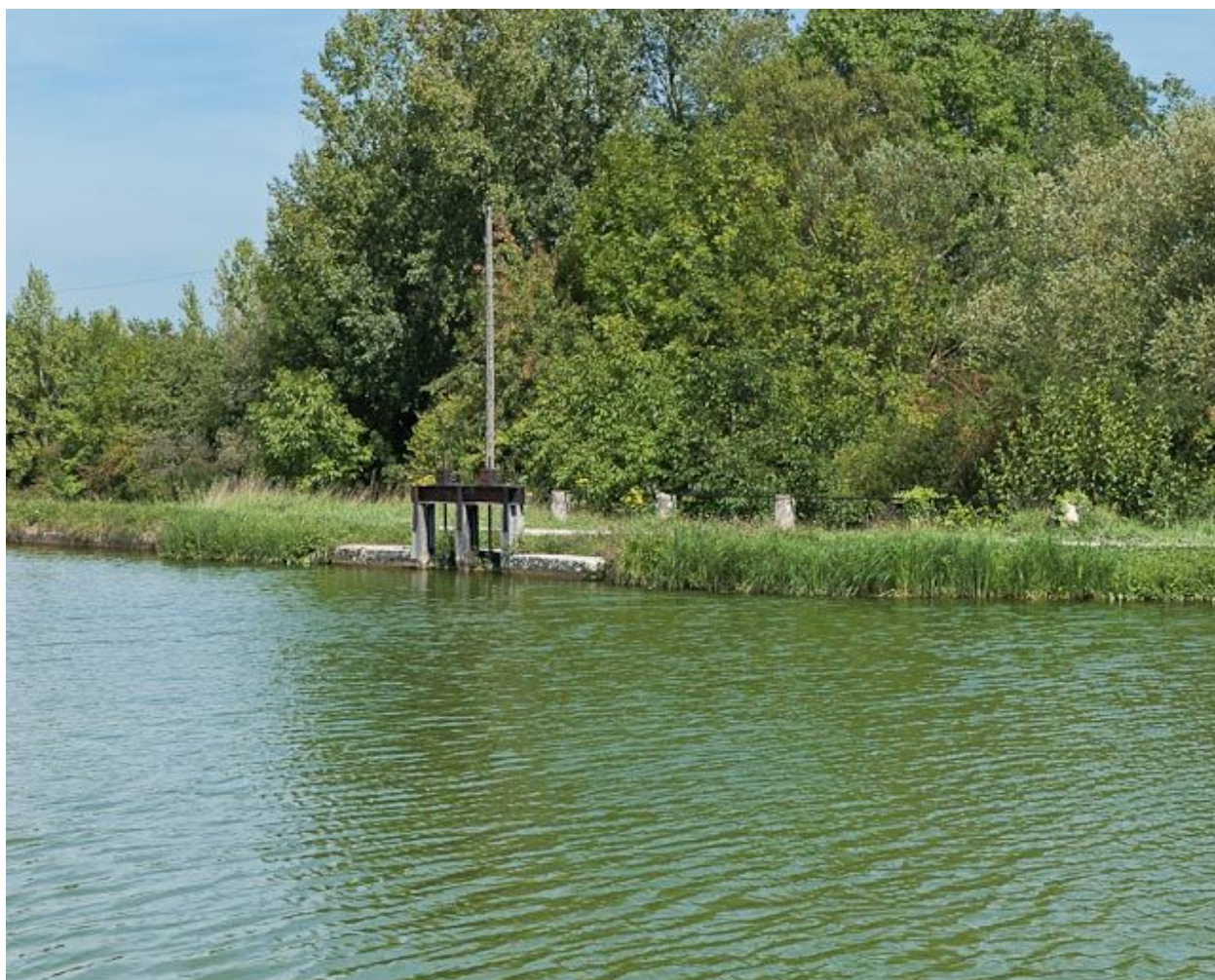
Vue du déversoir sur la rive droite
