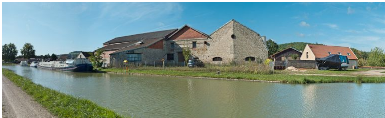
Vue de l'ancienne usine à chaux.
