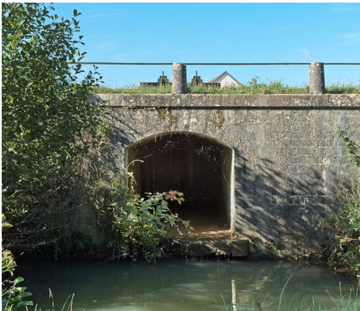
Vue de l'aqueduc.
