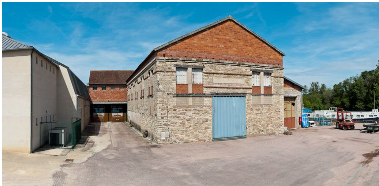
Vue de l'ancienne usine à chaux.
