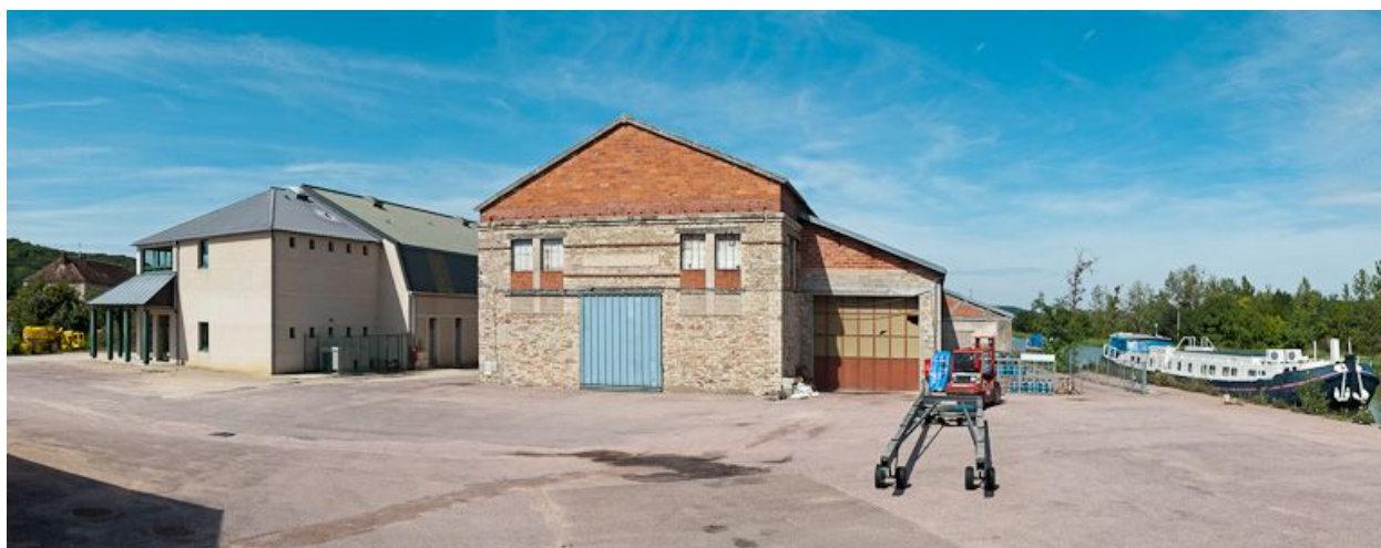
Vue de l'ancienne usine à chaux.
