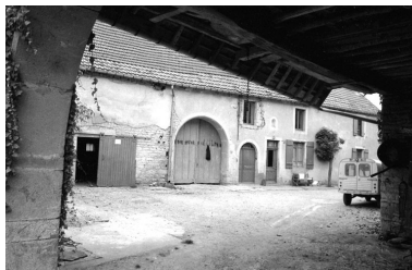
Bâtiment de gauche : façade sur cour. Phot. Bernard Lardière IVR43_19797000037Z
