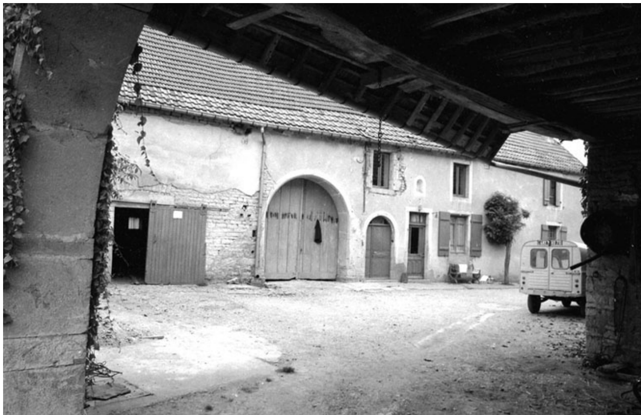
Bâtiment de gauche : façade sur cour.
