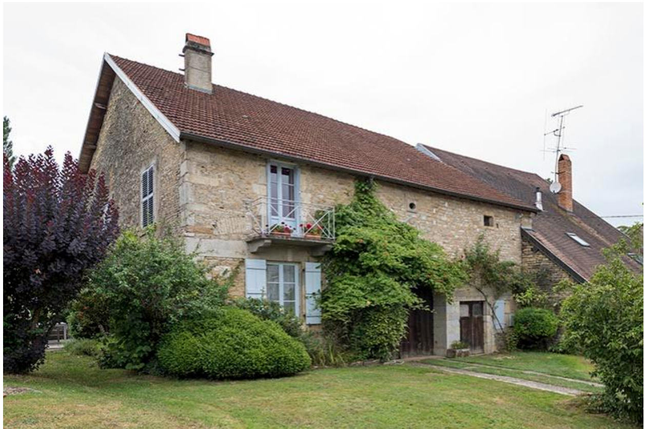
Façade sur rue de trois-quart
