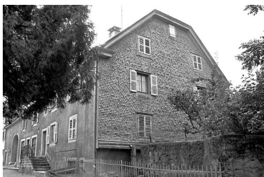
Façades antérieure et latérale droite.
