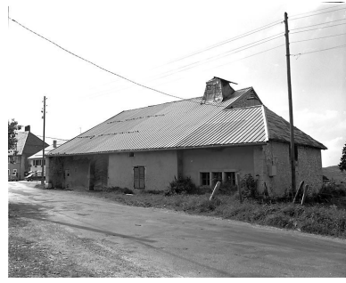
Ferme située 11 rue Principale. Phot. Yves Sancey IVR43_19782500407X
