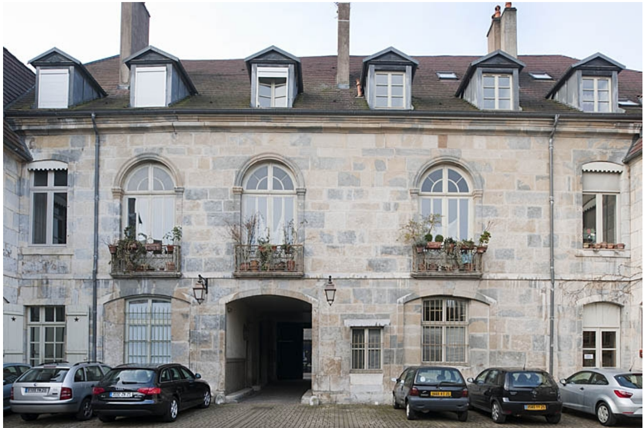
façade postérieure de l'hôtel : de face.
