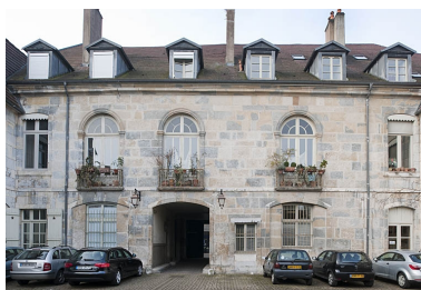
façade postérieure de l'hôtel : de face. Phot. Jérôme Mongreville IVR43_20112500229NUC4A
