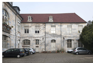
Aile gauche de l'hôtel : de face. Phot. Jérôme Mongreville IVR43_20112500228NUC4A
