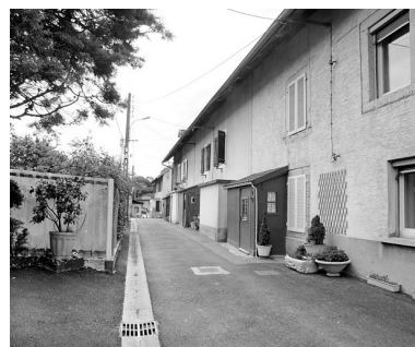
Façades est rue des Bouleaux. Phot. Yves Sancey IVR43_20029000324X
