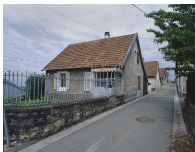
Maison individuelle rue des Mélèzes. Phot. Yves Sancey IVR43_20029000328XA
