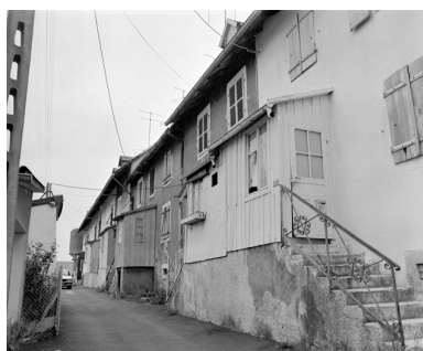
Caserne" rue des Bouleaux : vue depuis le sud en 1981.SRI. Enquête régionale sur les bâtiments industriels (1979-1981). Phot. Yves Sancey IVR43_19819000045X
