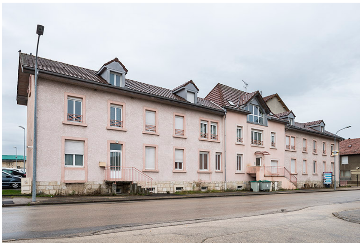
Façade antérieure des bureaux.
