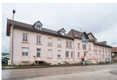
Façade antérieure des bureaux.
