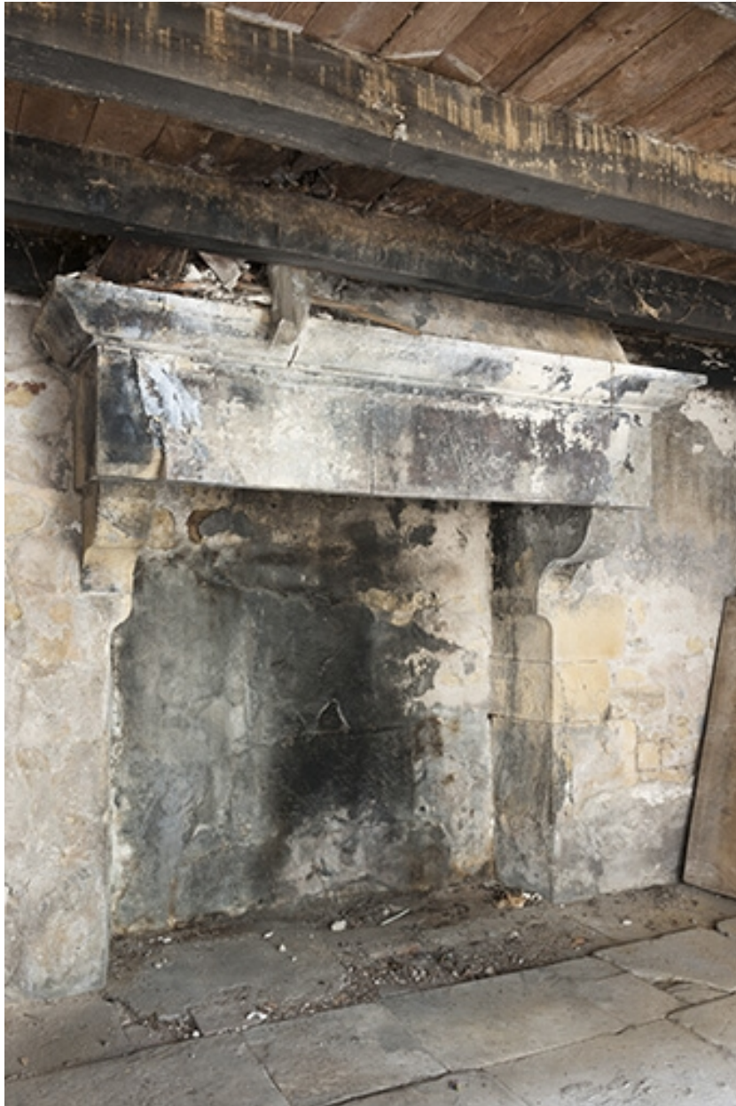
Intérieur de la buanderie : cheminée.
