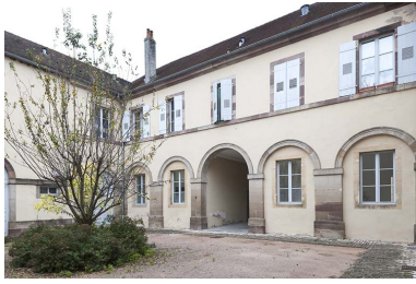
Façade postérieure et aile sud. Phot. Jérôme Mongreville IVR43_20127000366NUC4A
