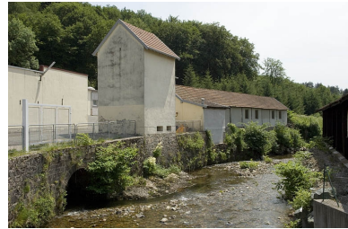
Bâtiments industriels depuis le pont d'accès. Phot. Jérôme Mongreville IVR43_20067000556NUCA
