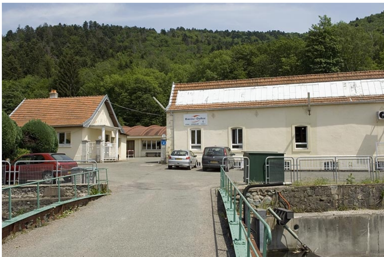
Vue d'ensemble depuis l'entrée du site.
