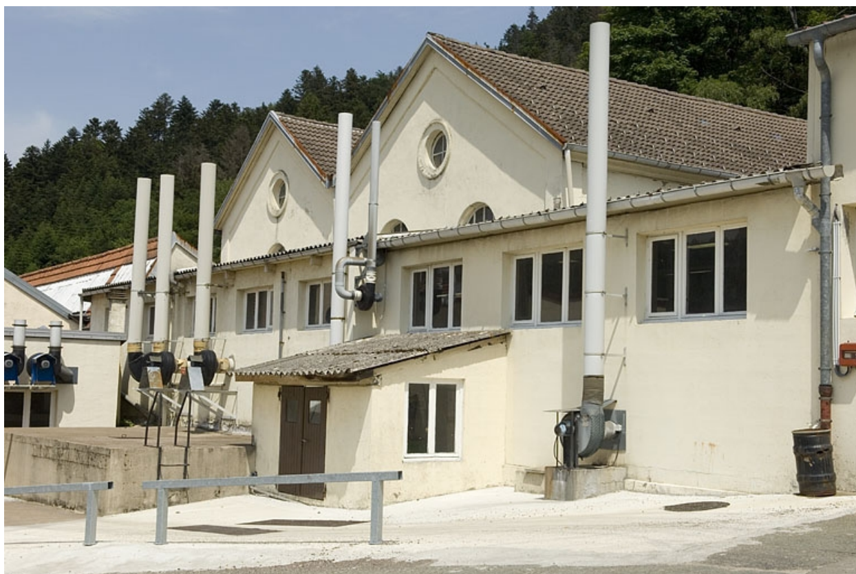
Anciennes chaufferie et salle des machines.
