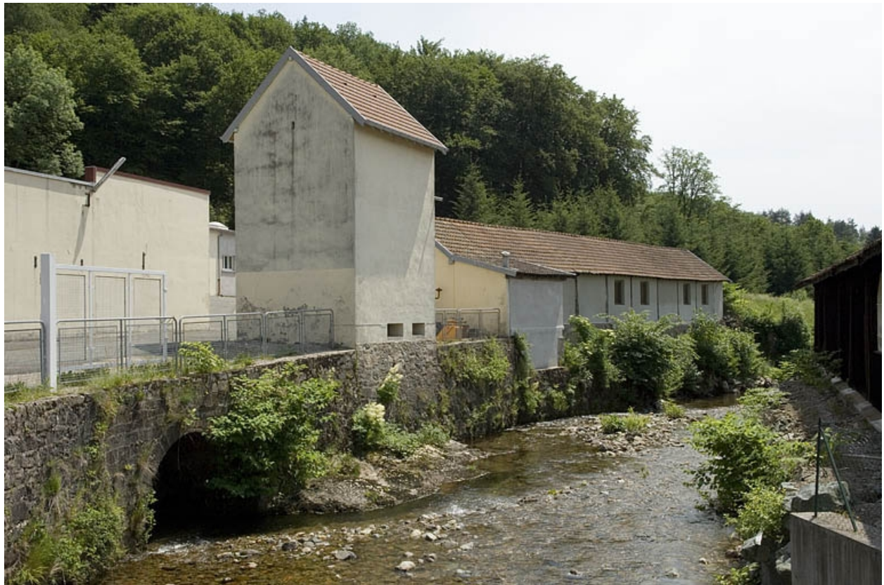
Bâtiments industriels depuis le pont d'accès.
