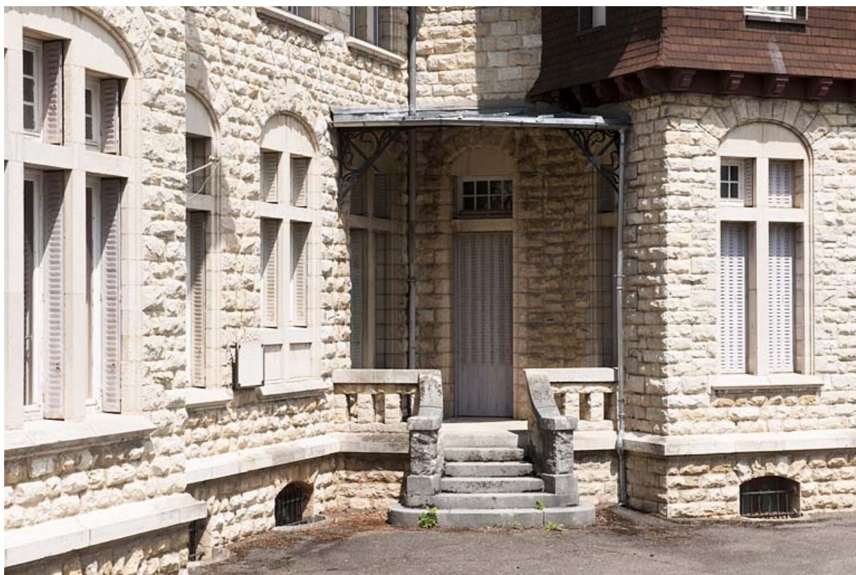
Détail de la façade sud.
