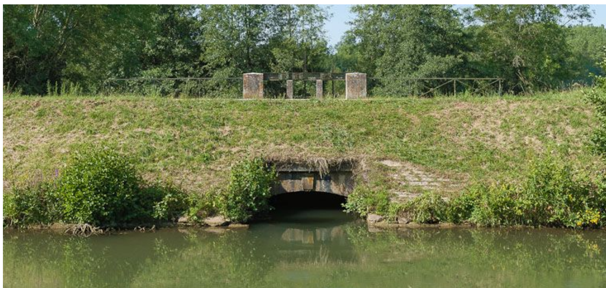
Sortie du déversoir.
