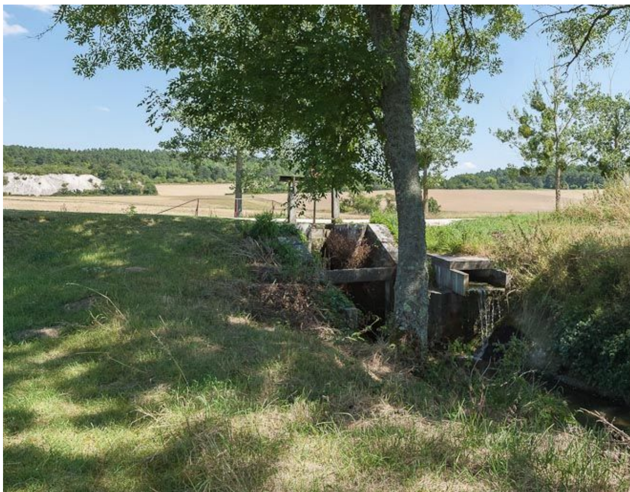
Déversoir avec vanne rive gauche.
