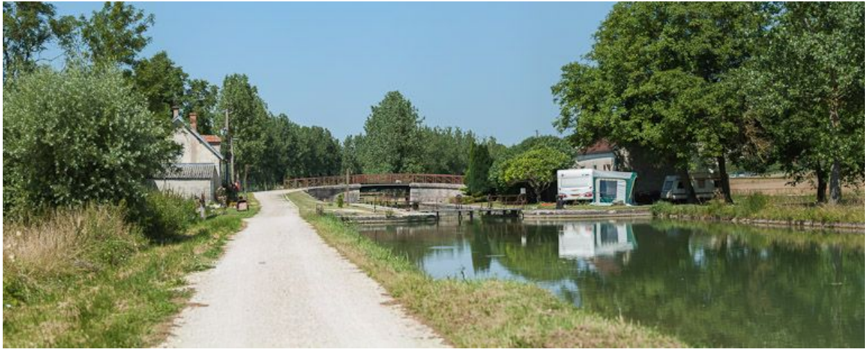
Site d'écluse vu d'amont.
