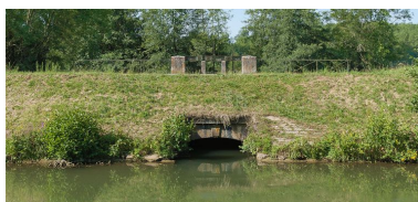
Sortie du déversoir. Phot. Pierre-Marie Barbe-Richaud IVR26_20128900363NUC4AQ
