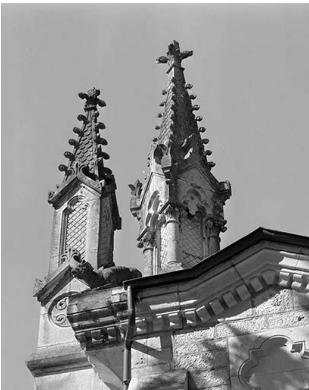
Façade antérieure, détail : les clochetons.
