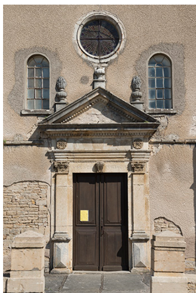
Vue avant restauration (2016). Phot. Jérôme Mongreville IVR43_20187000144NUC4A
