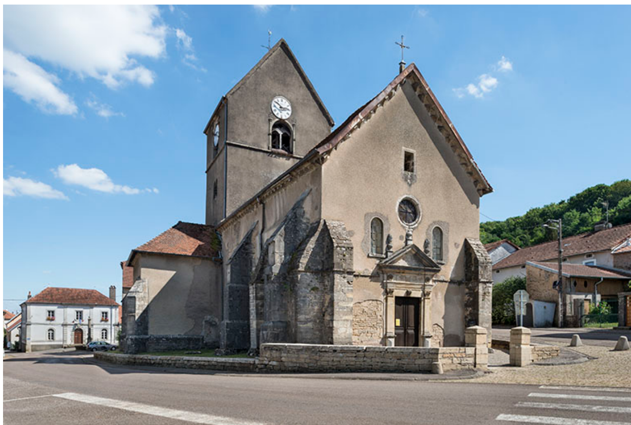
Vue avant restauration (2016).
