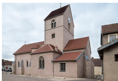
Vue latérale depuis la rue des Ecoles. Phot. Jérôme Mongreville IVR43_20187000129NUC4A
