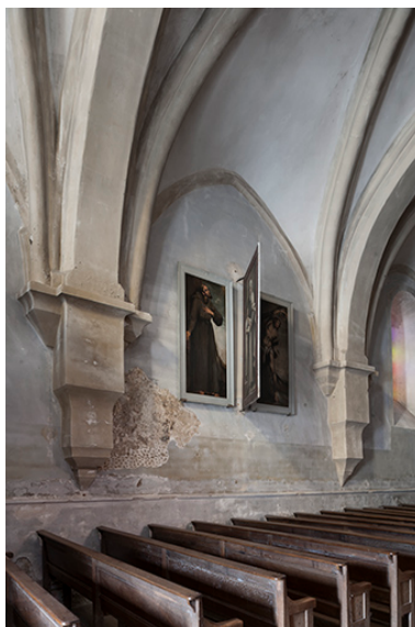
Une des trois travées de la nef. Phot. Jérôme Mongreville IVR43_20177001260NUC4A
