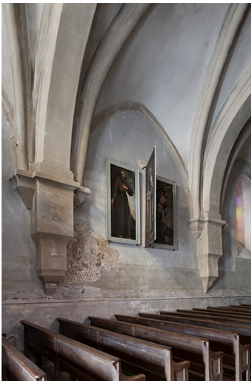
Une des trois travées de la nef.
