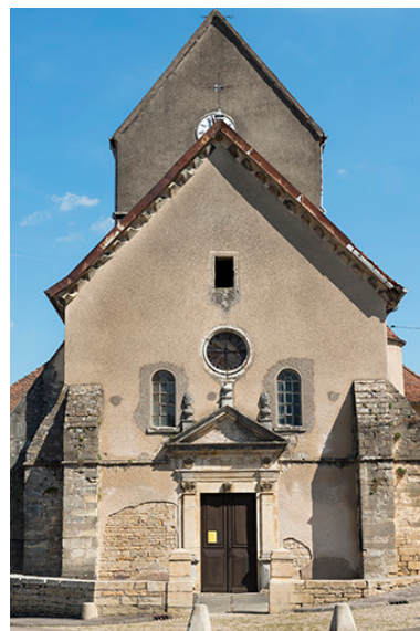
Vue avant restauration (2016). Phot. Jérôme Mongreville IVR43_20187000142NUC4A
