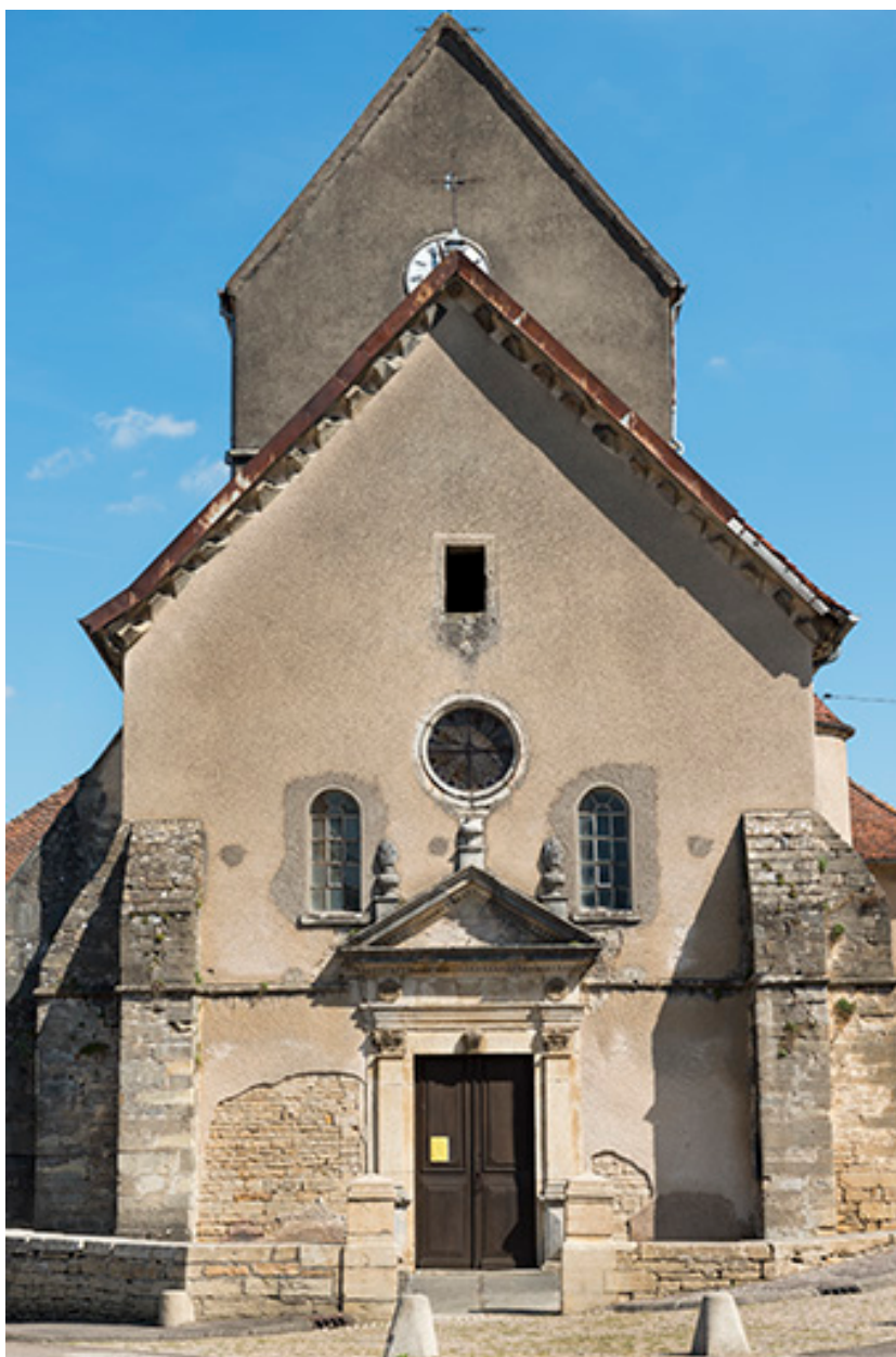
Vue avant restauration (2016).
