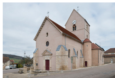
Vue d'ensemble. Phot. Jérôme Mongreville IVR43_20187000130NUC4A
