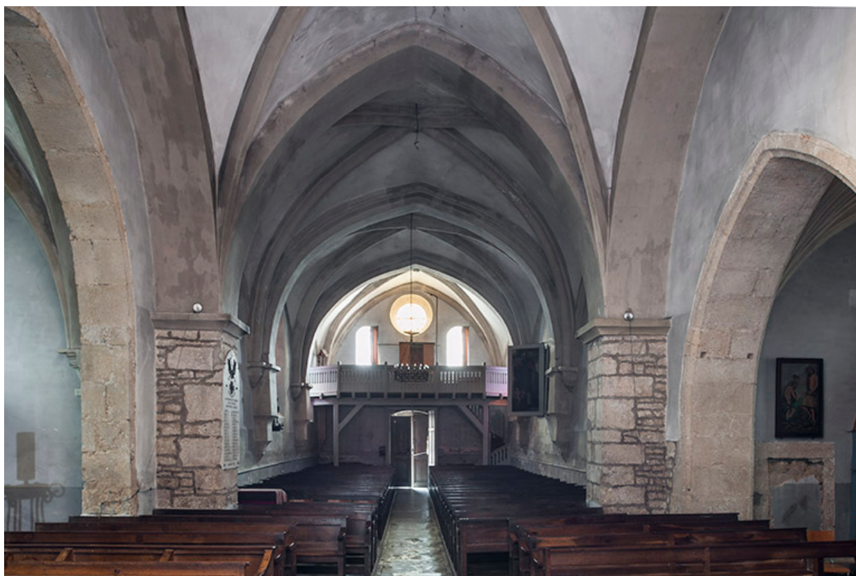
Vue intérieure depuis le chœur.
