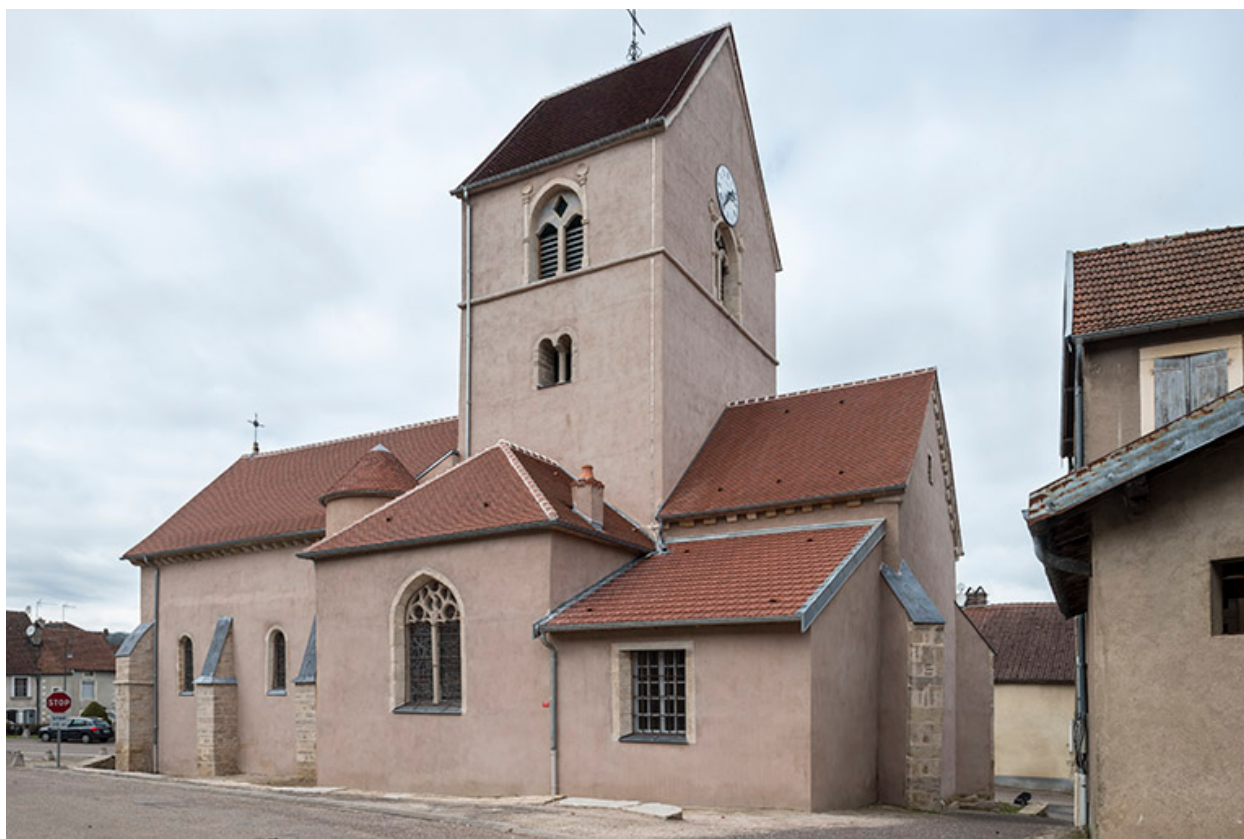
Vue latérale depuis la rue des Ecoles.
