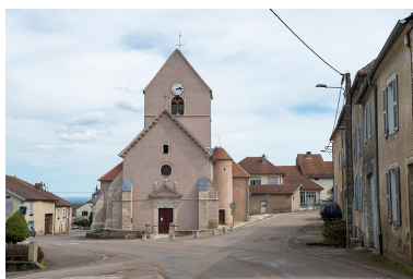
Vue générale. Phot. Jérôme Mongreville IVR43_20187000184NUC4A
