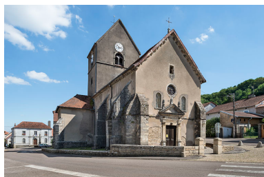
Vue avant restauration (2016). Phot. Jérôme Mongreville IVR43_20187000139NUC4A
