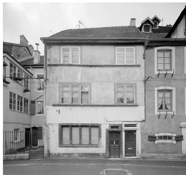
Façade sur rue. Phot. Jérôme Mongreville IVR43_19872501093V
