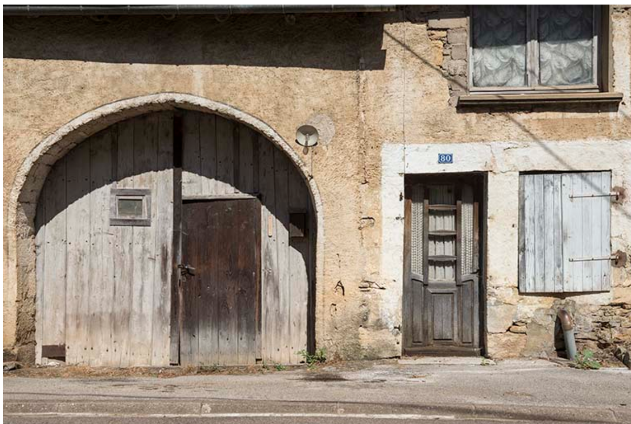
Ferme à deux travées, Grande rue.
