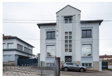
Façade antérieure (les bureaux). Phot. Jérôme Mongreville IVR43_20172501370NUC4A
