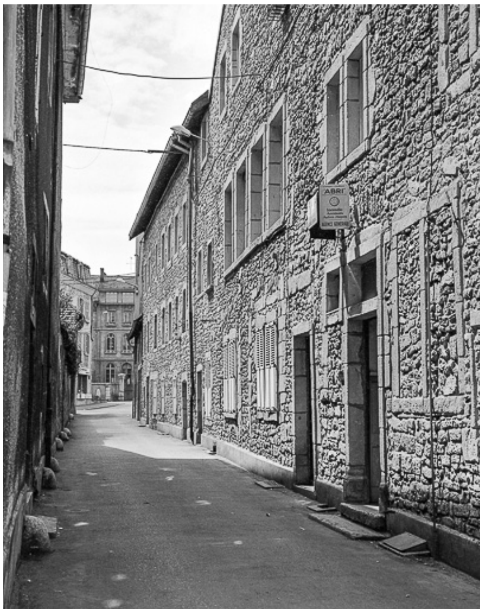
Vue depuis la rue de la République.
